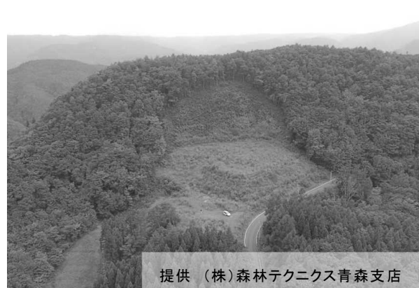
写真 ⑪ 復旧状況 日影森区域
