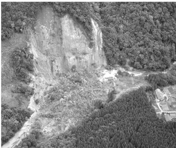
写真 ⑭ 被災状況 浅布区域
