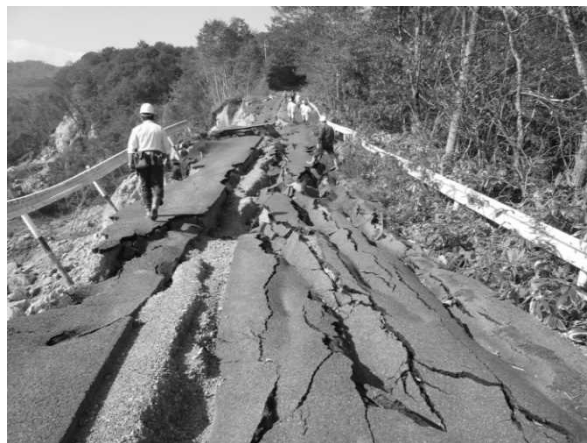
写真 ② 治山技術エキスパート部隊による現地調査の様子
