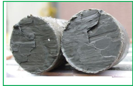
写真 4. a 地点（破断面付近） すべり面の痕跡
