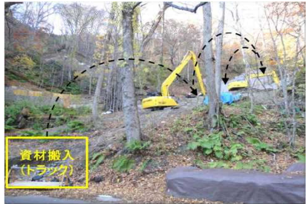
図－5 バックホウによる資材運搬
