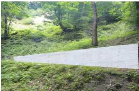
図-9 現場打ちコンクリート土留工
