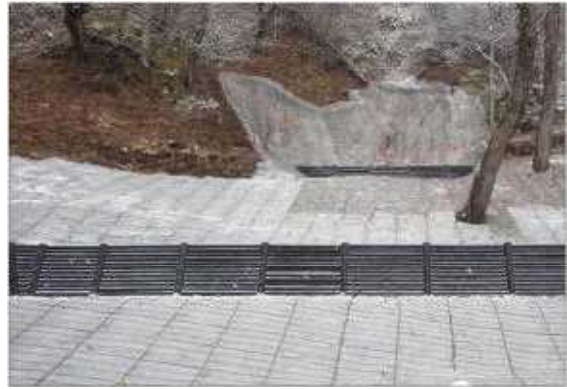
図-6 九十九島治山工事の完成
