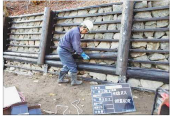
図－4 焼付け丸太の貼付け
