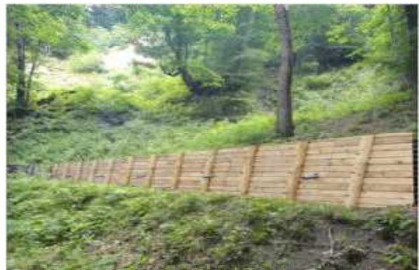
図-10 木製残存型枠コンクリート土留工
