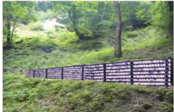
図-8 通常の鋼製枠土留工
