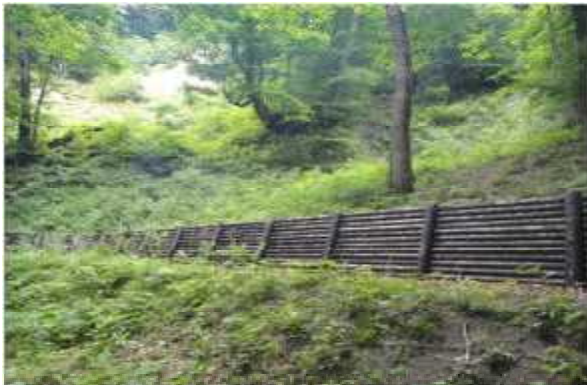
図-7 当該工法による鋼製枠土留工
