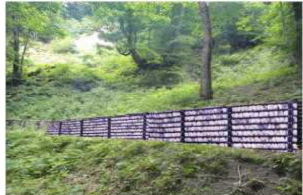
図-8 通常の鋼製枠土留工
