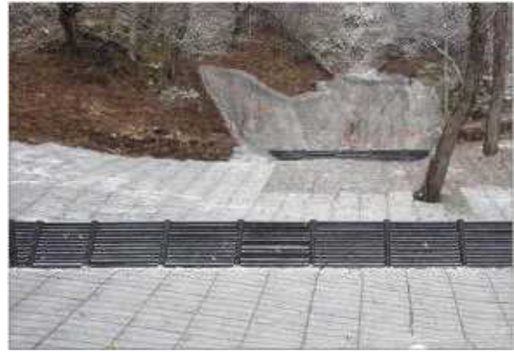
図-6 九十九島治山工事の完成
