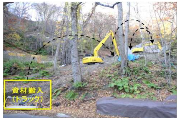
図－5 バックホウによる資材運搬
