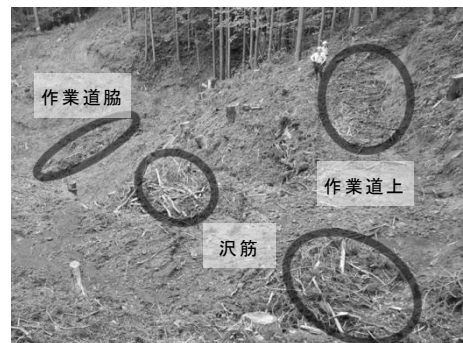
写真 1. 枝条の処理状況
