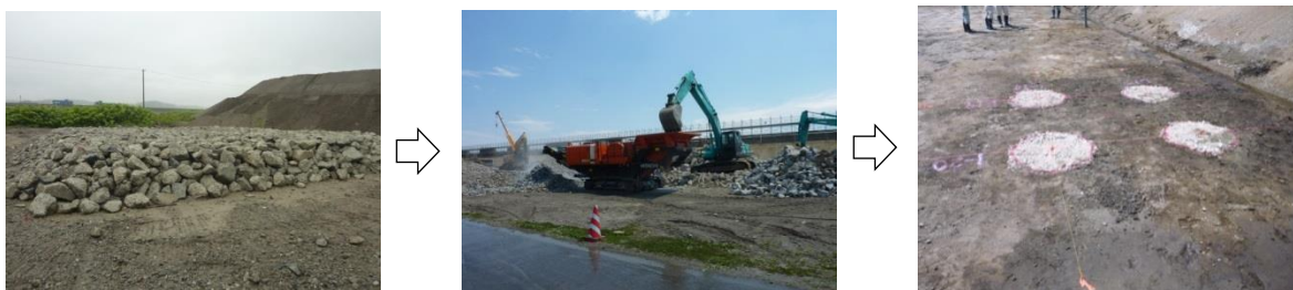
写真-4 防潮堤基礎工施工状況写真
