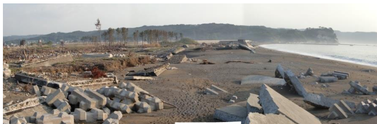
写真-3 被災状況 2
