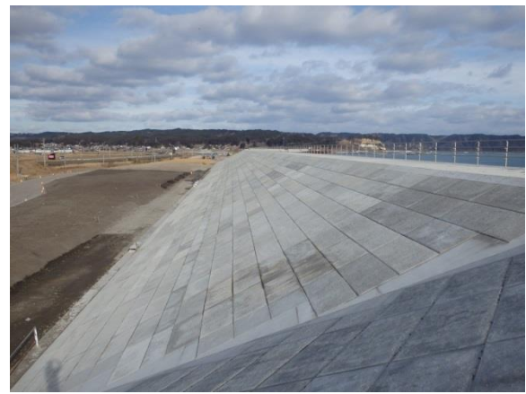
写真-7 陸側防潮堤完成状況
