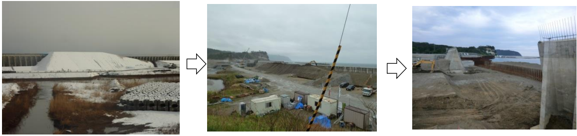
写真-5 プレロード施工状況写真
