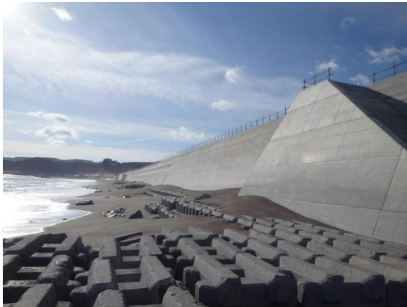
写真-6 海側防潮堤完成状況
