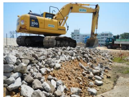
図－7 コンクリートがら
