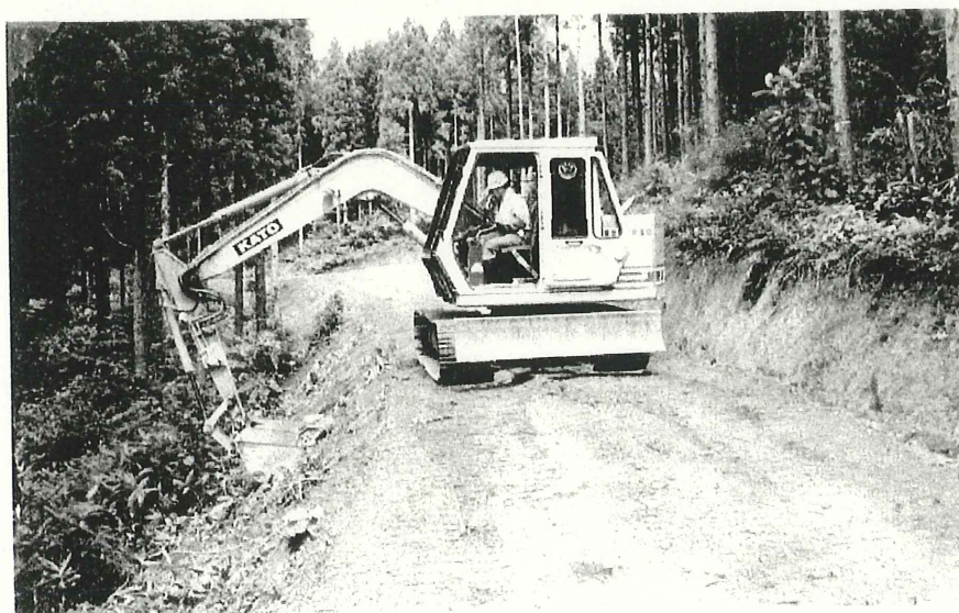
盛土法面仕上げ
