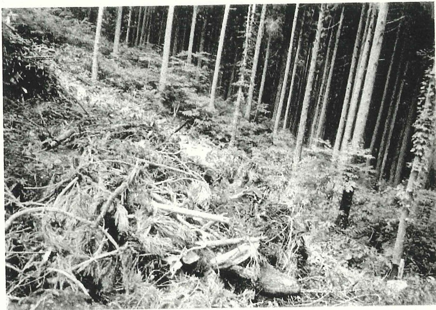
伐根，末木，枝 条を活用した基 礎造り
