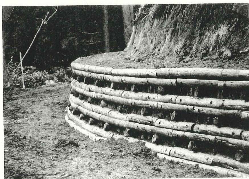
ウッドブロック積 (完成)
