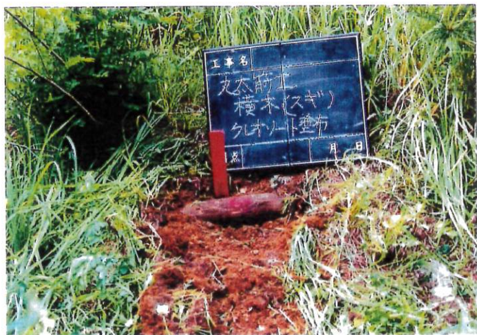
① 扇田署 腐朽もなく特に異常は認められない。
