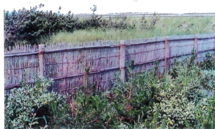
② 能代署 防風垣の施工状況。
