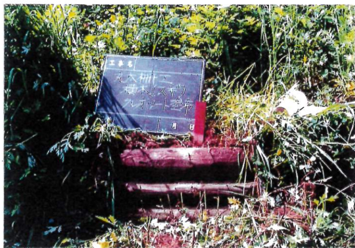
② 扇田署 腐朽もなく特に異常は認められない。
