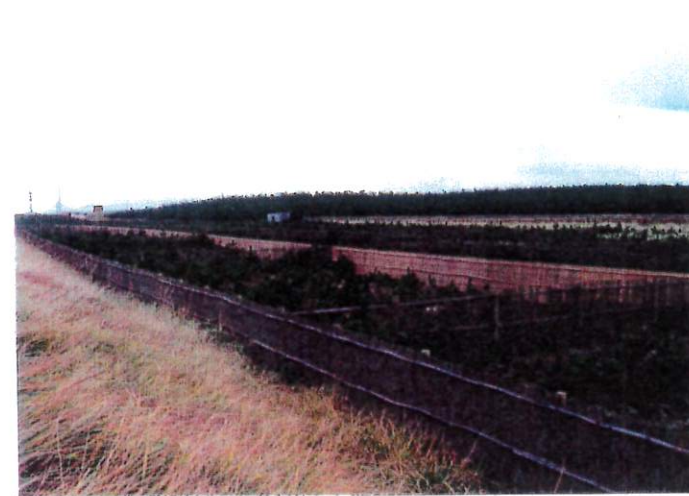
③ 能代署 防風垣の施工状況。
