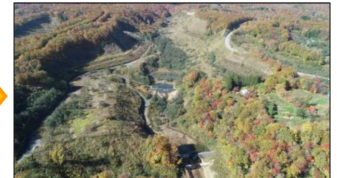
治山施設整備後の状況(平成30年)
