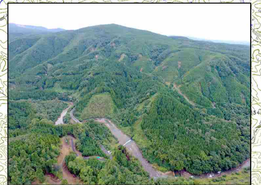
三迫川左岸の復旧状況
