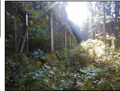
一迫川左岸 国道398号沿いの斜面对策 (地山補強土工、落石防止)
