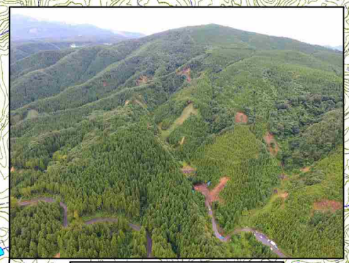
治山運搬路沿いの溪流 治山ダム・山腹工施工状況
