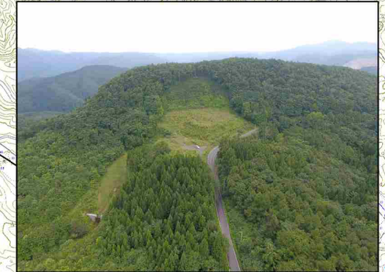
市道馬場駒の湯線沿いの山腹工施工地
