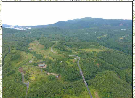
冷沢一帯の復旧状況
