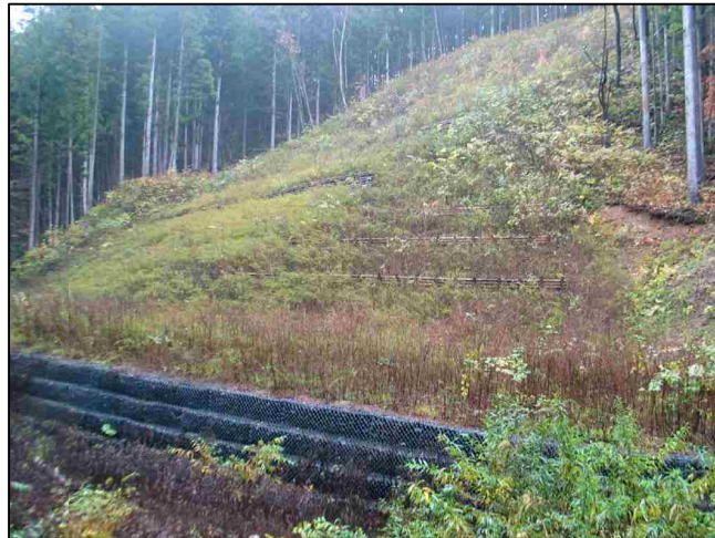
二迫川左岸 治山ダムと山腹工が一体となった施工地 (No. 1谷止工・No. 2山腹工)
