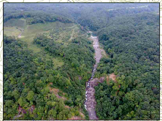
御沢 窓滝上流の治山ダム 及び右岸の山腹工群
