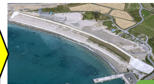
三島海岸（CSG堤）
