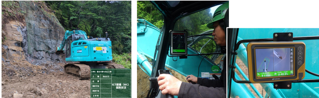
ICTバックホウによる掘削
