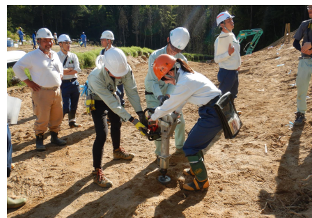
木杭根系工法の人力施工体験
