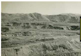
荒廃状況（昭和30年）
