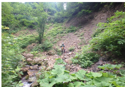
溪岸崩壊状況
