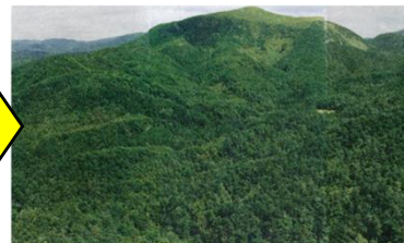
復旧状況（平成26年）
