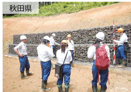
山地災害調査アプリを用いた実習
