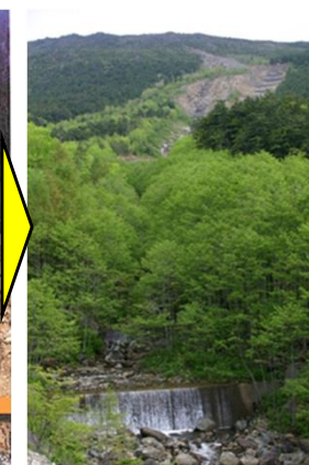
復旧状況（平成22年）
