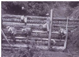
施工状況（昭和28年）
