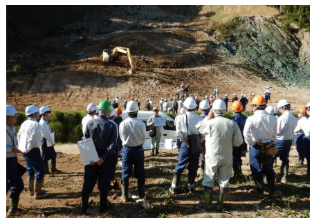
治山工事施工地での検討会の様子
