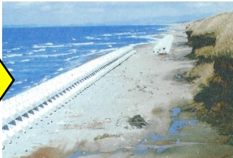
施工後（平成20年代）
