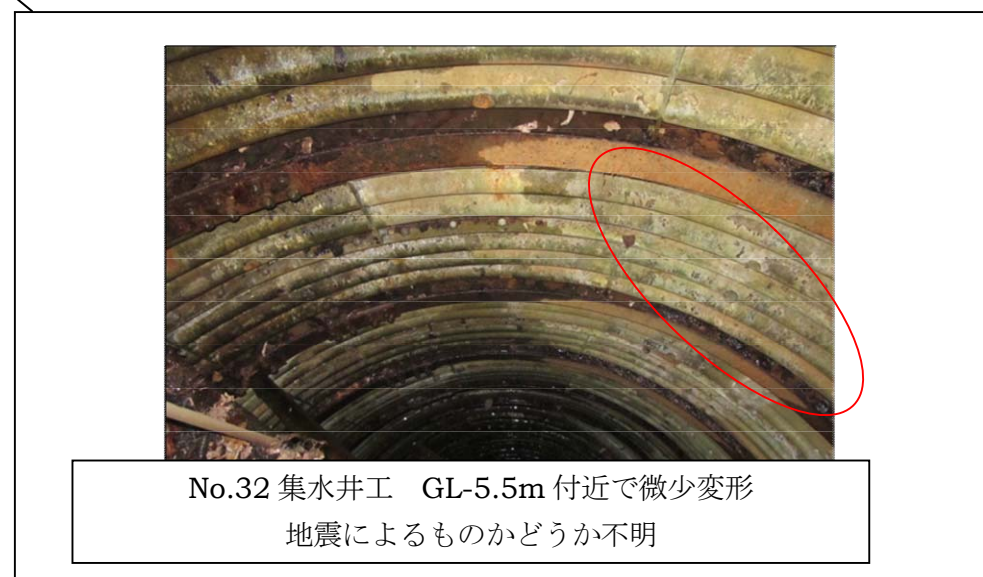
図 3.2 旧 I-2 ブロックの集水井の被災状況
