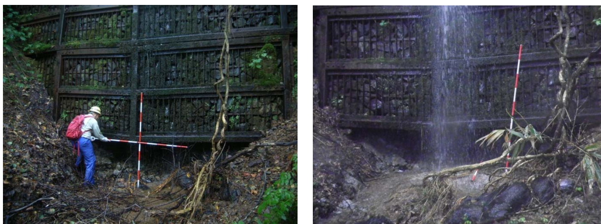
写真 6.8 ホドホリバ 5号ダム (基礎部の洗掘)
