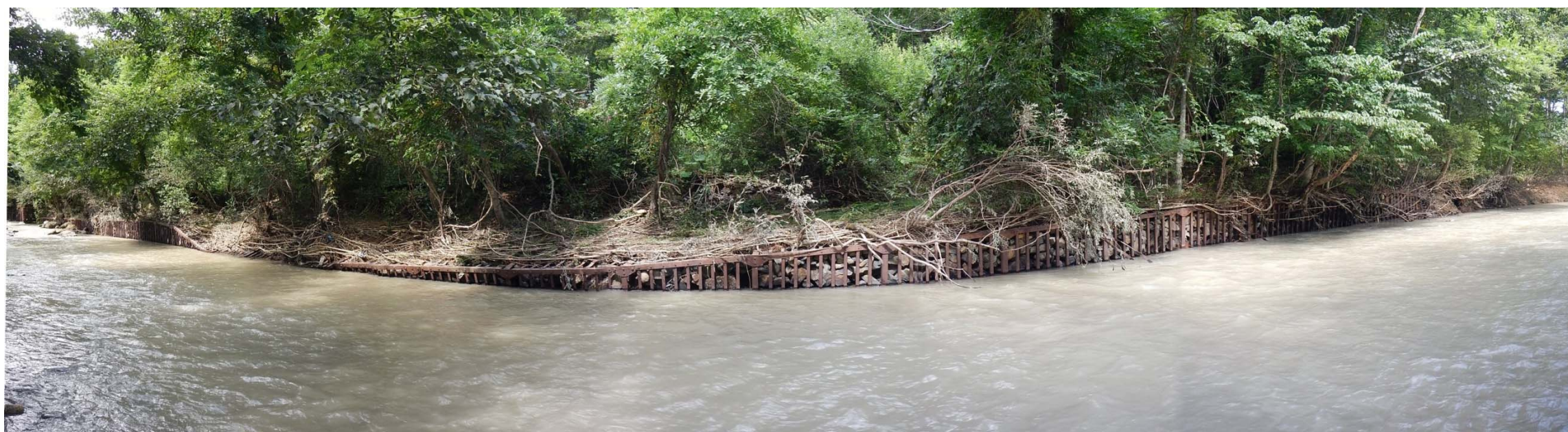
写真 6.5 産女川 1 号護岸工：洗掘により沈下し、施設機能が大きく損なわれているため、平成 28 年度に補修設計を実施、平成 29 年度に補修工事予定。
