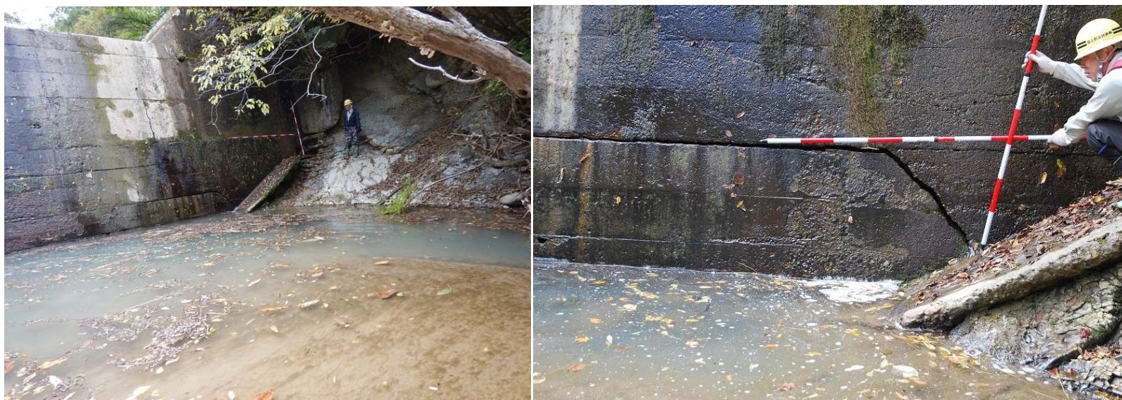
写真 6.6 産女川 5号治山ダム (堤体に亀裂が認められる)
