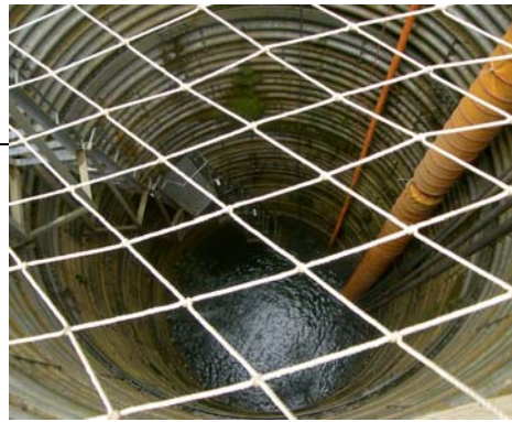
H27.9.11 に 7 号集水井が湛水
