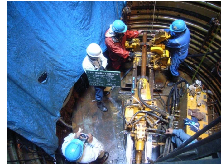
写真 6.3 岡山 12 号集水井内の追加集水ボーリング工
