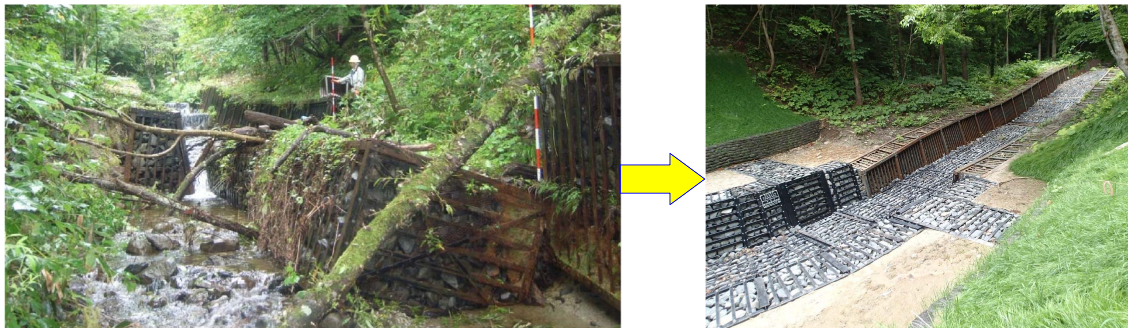
写真 6.4 五串沢流路工（昭和 58 年、平成 9 年、平成 13 年に施工）：被災状況と復旧工事完了後（平成 28 年に補修）
