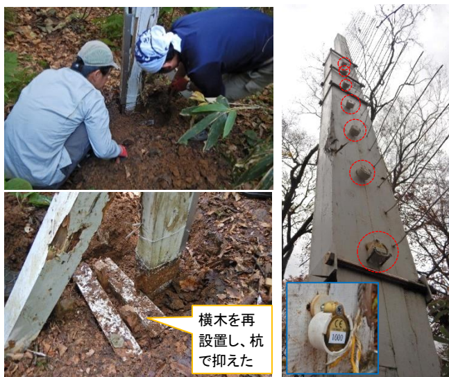
写真4 積雪深計の補修(秋B-1)とロガーの設置状況(B-10)
