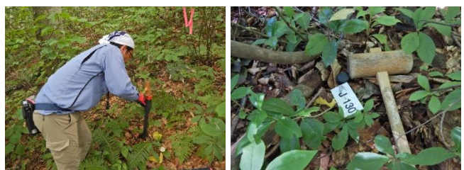
写真10 格子点杭の再設置状況
