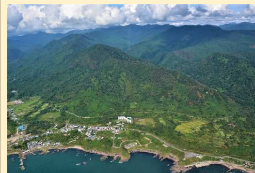
被害状況写真(八峰町、R5.9.18撮影)
