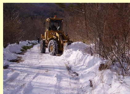
林道の除雪(遠野支署管内)
