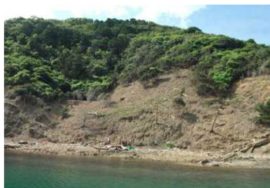
長崎県対馬 シカ食害による地表流出により斜面崩壊の恐れ
