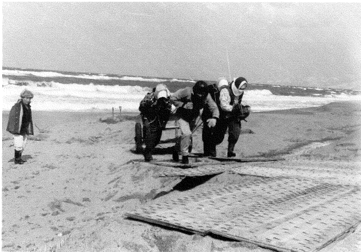
人力による復旧作業。(大開浜 S.36)
