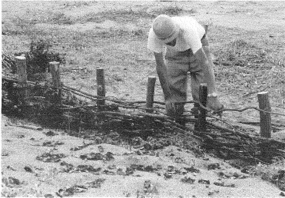
杭の間に柴を編み上げる。(大開浜 S.38)
