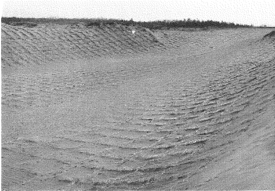
砂丘の間に施されたワラ静砂立工。(後谷地 S.26)
