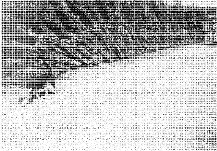
堆砂垣の材料の柴。主に峰浜村から購入した。(S.38)
