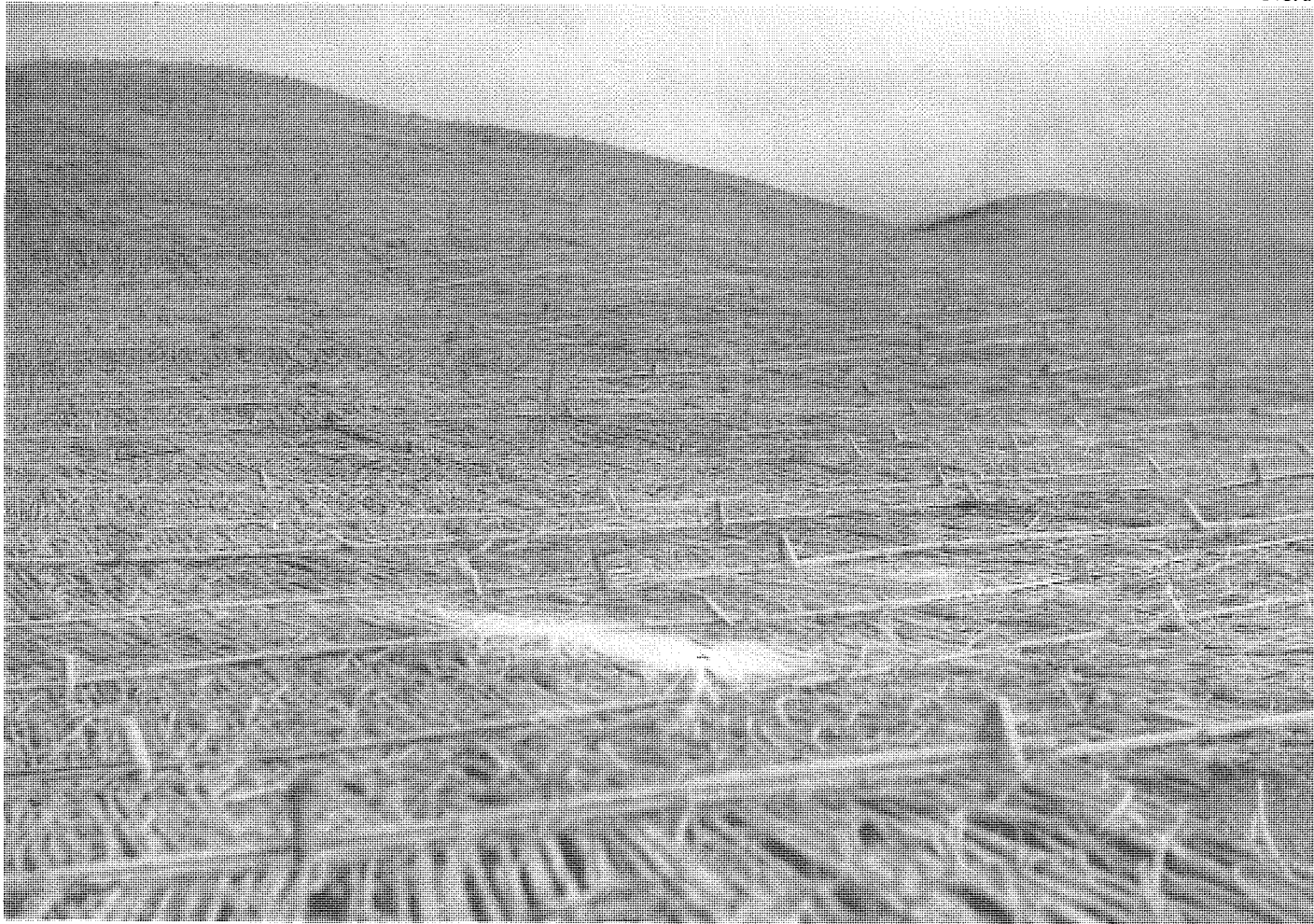
砂丘の表面をカヤ簀で覆い、砂の移動を防ぐ。
