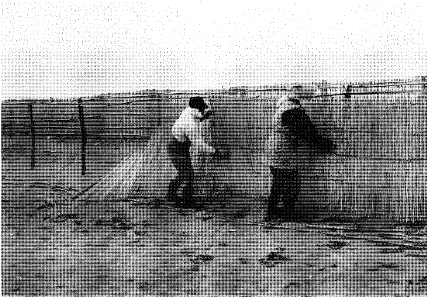
ヨシ簀を用いて防風柵を作る作業。
