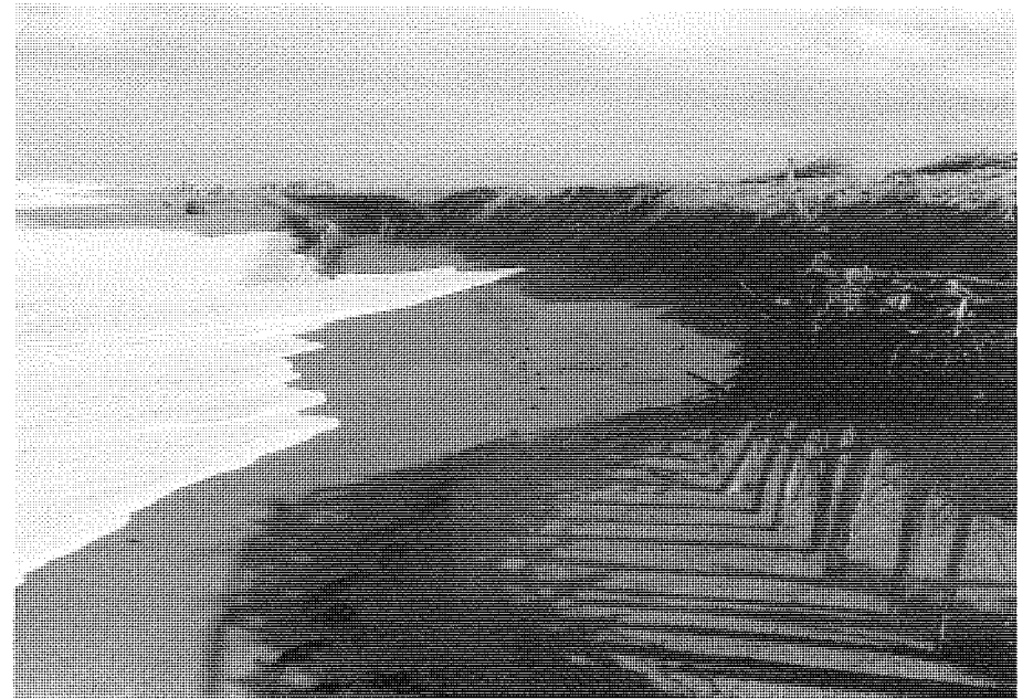
波浪によって破壊された防浪垣。(後谷地)
