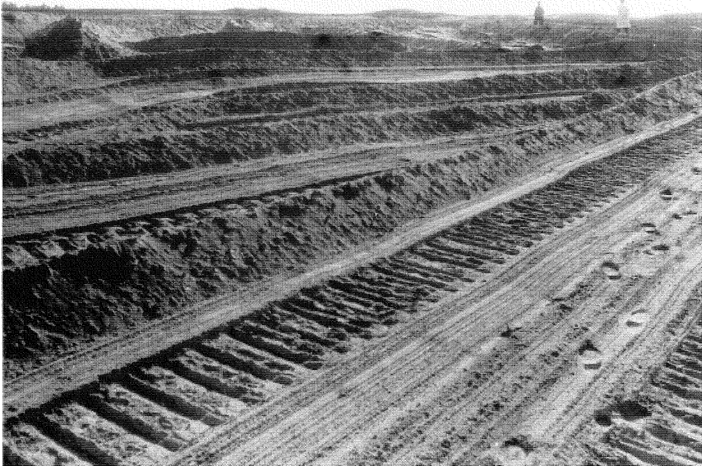
ブルドーザーによる砂丘の造成作業。(大開浜 S.34)
