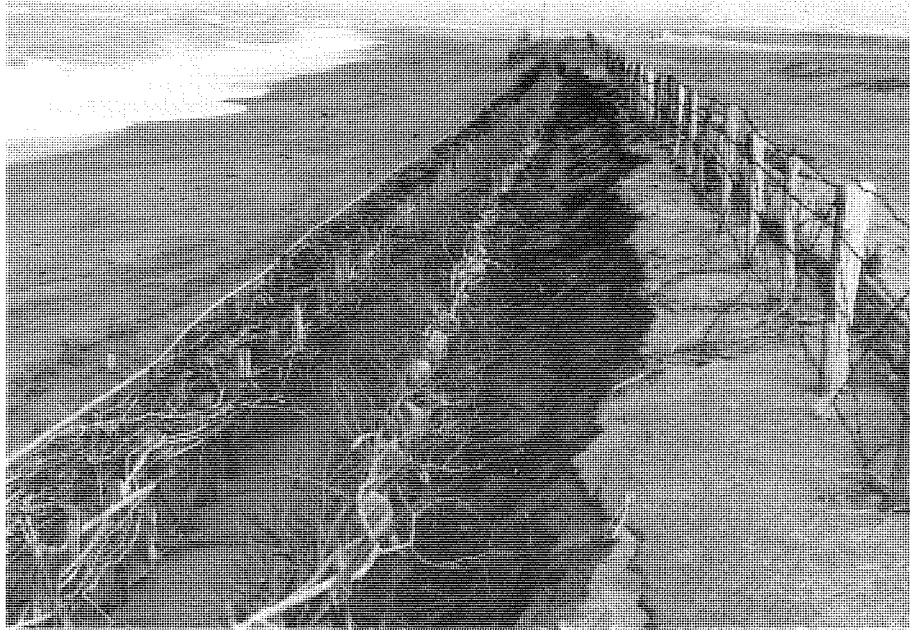
復旧のために造成された防浪垣。(大開浜 S.37)
