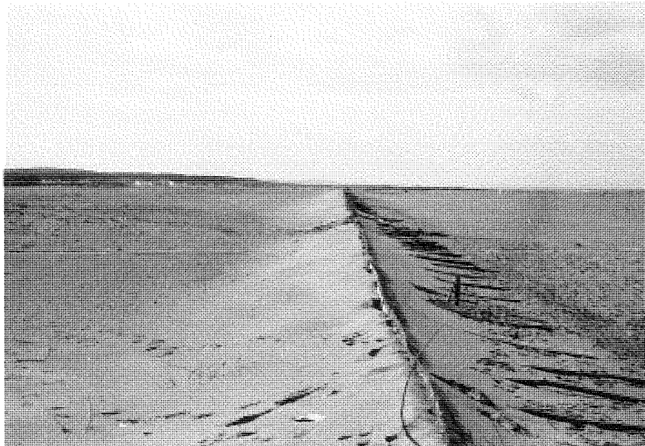
堆砂垣を設けて、その前後に砂を堆積させ、砂丘を造成する。まず、一列目の堆砂垣を造成する。(大開浜)
