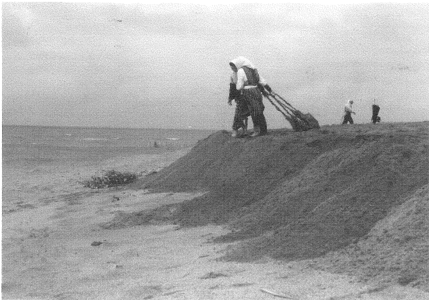
モッコで砂を運び,凹地を埋める。(後谷地 S.33)
