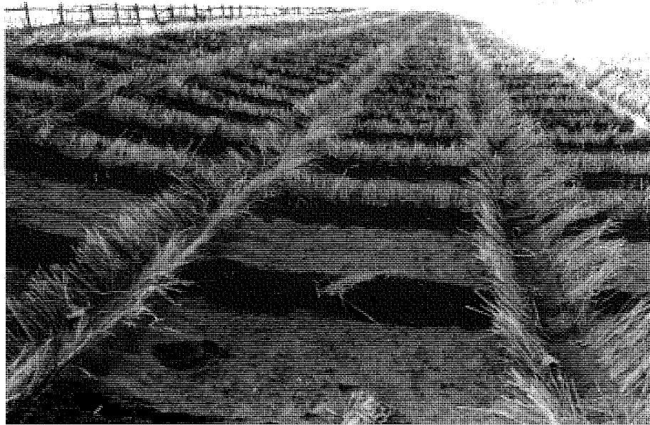
施工中のワラ静砂立工。(大開浜 S.33)
