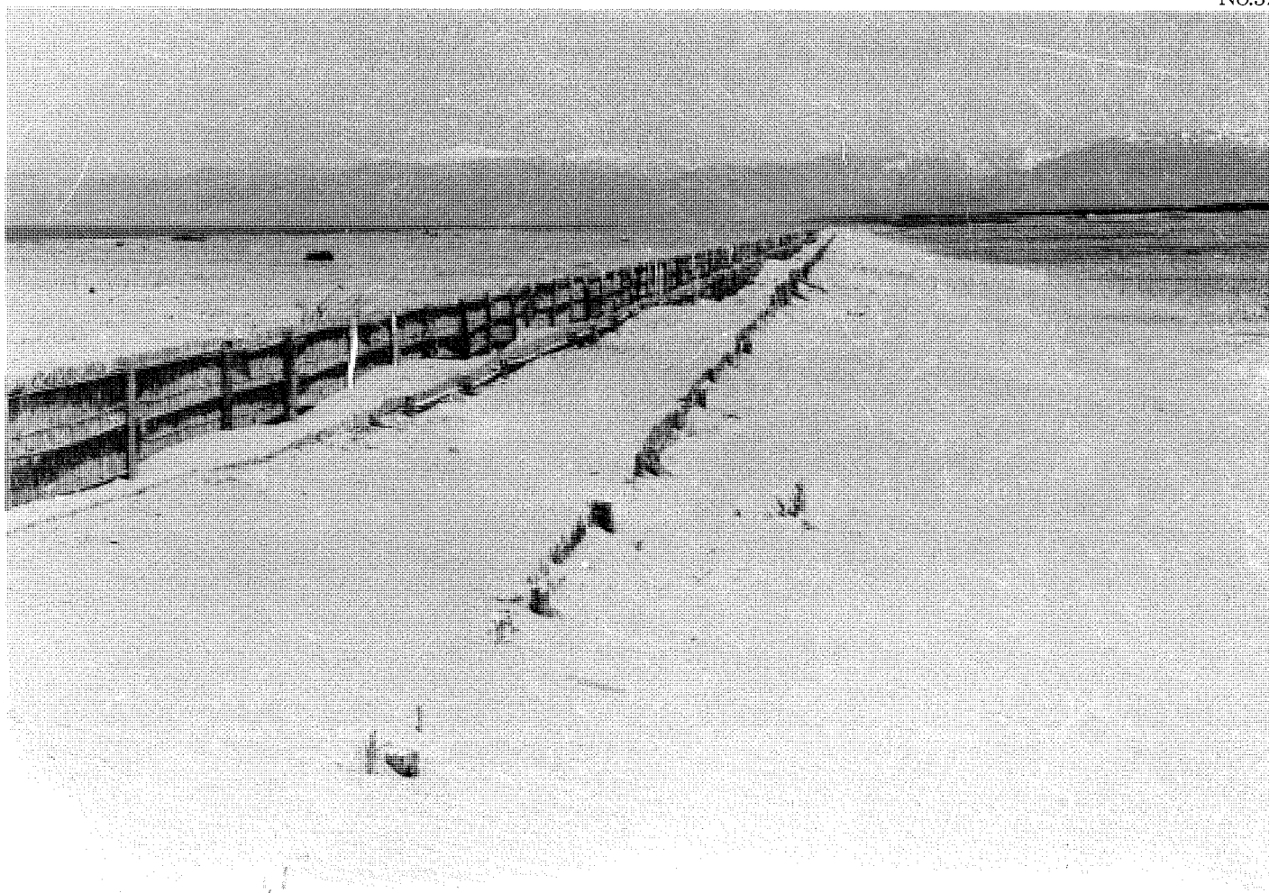
ヨシ簀で作られた堆砂垣と堆砂の様子。(大開浜 S.33)
