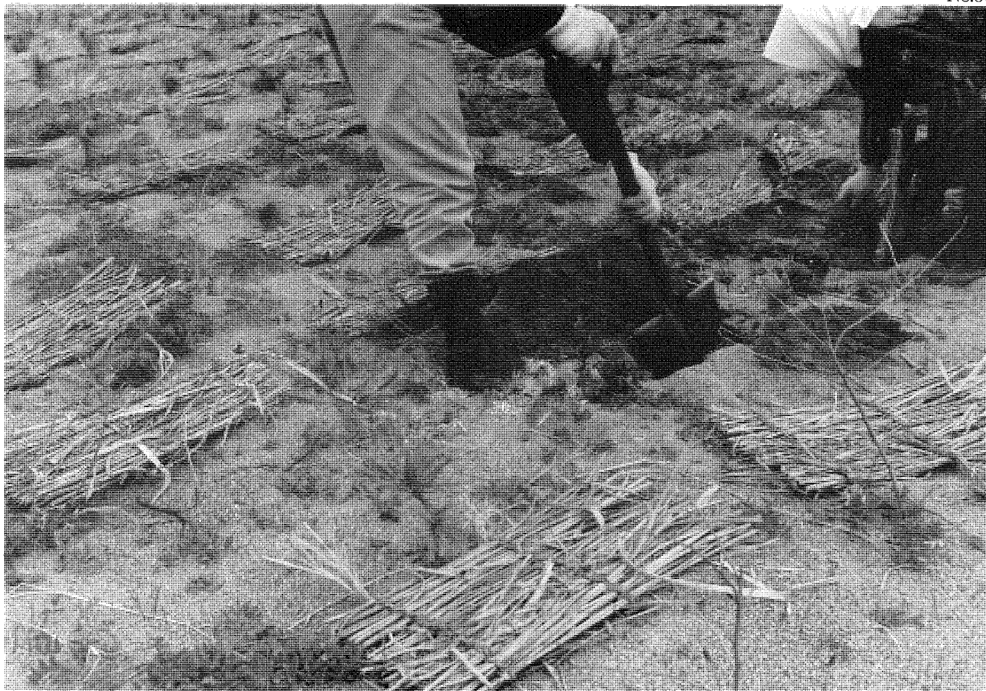
植栽したクロマツの風上にヨシを編んだ衝立を立てる。(S.38)
