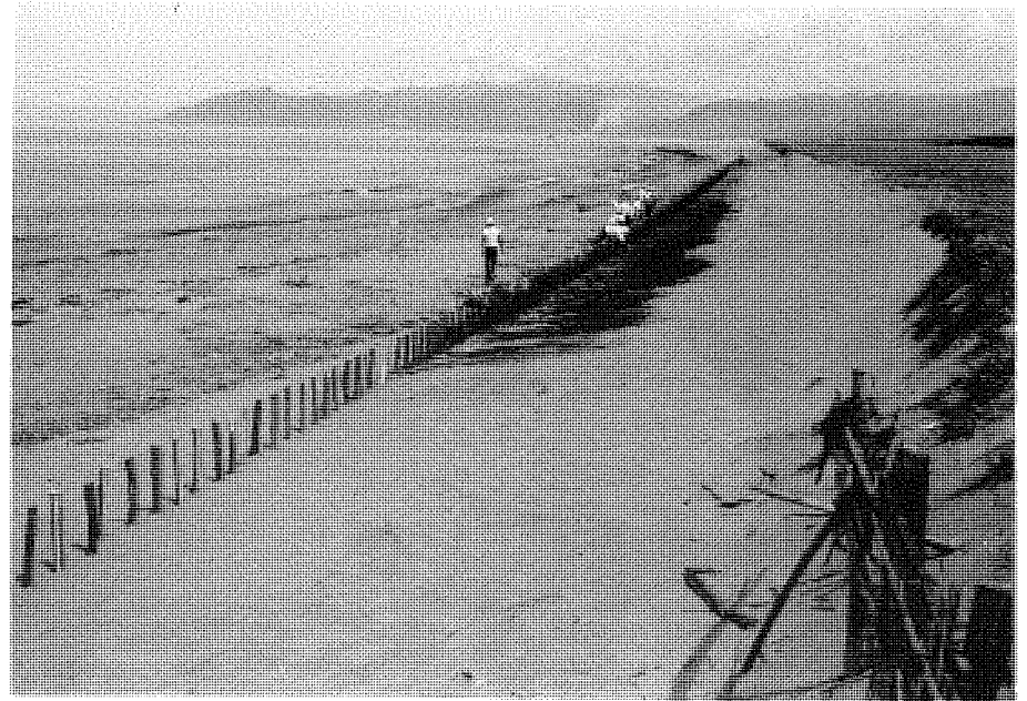
杭を打ち終わり、柴で編む。(大開浜 S.38)
