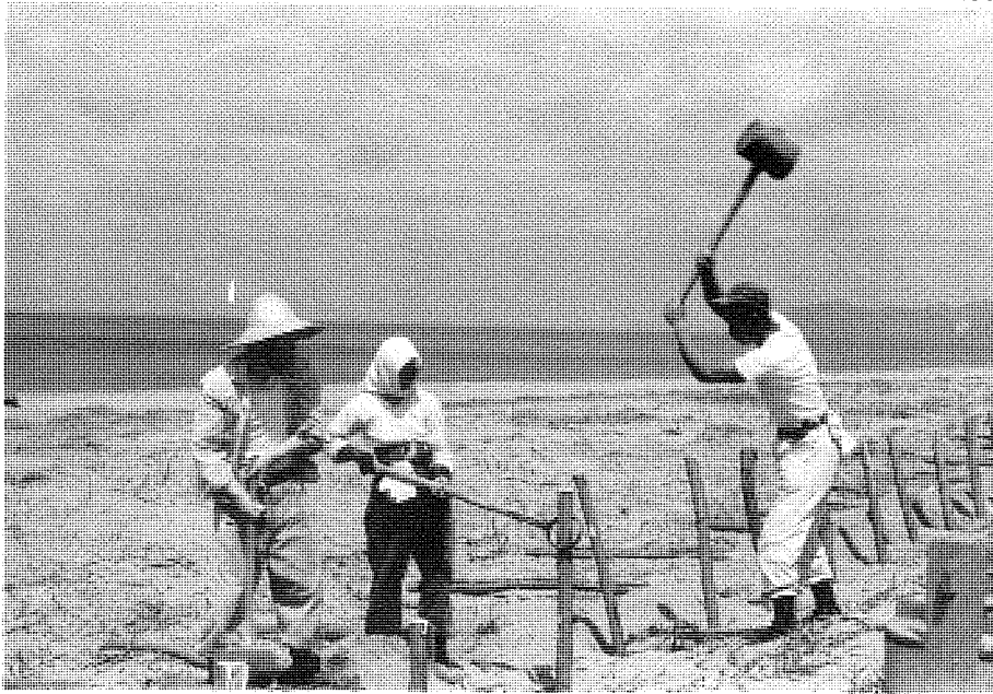
杭を打ち込む。(大開浜)
