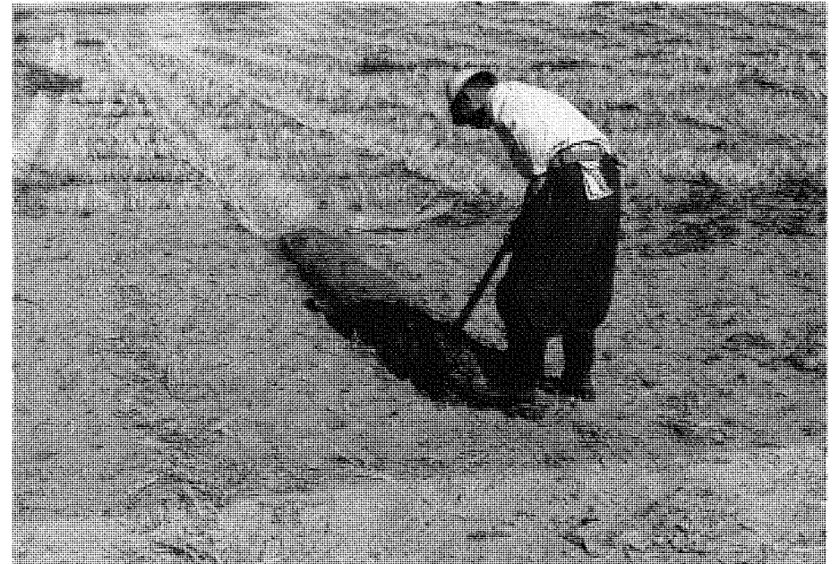
ワラ静砂立工の作業。(S.31)
