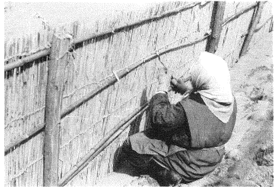
ヨシ簀堆砂垣の作成作業。(大開浜)
