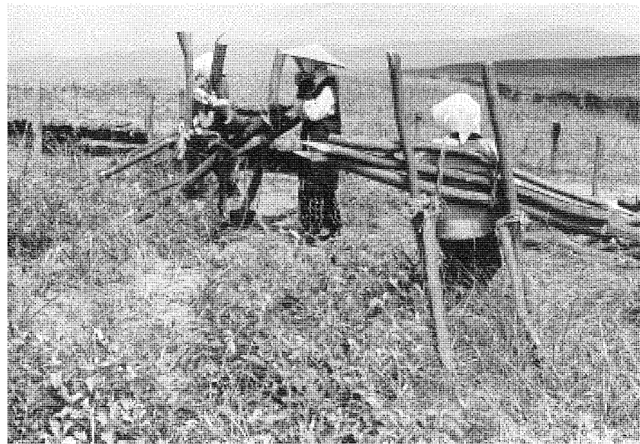
垣造成の現場まで背負って運搬した。(大開浜)
