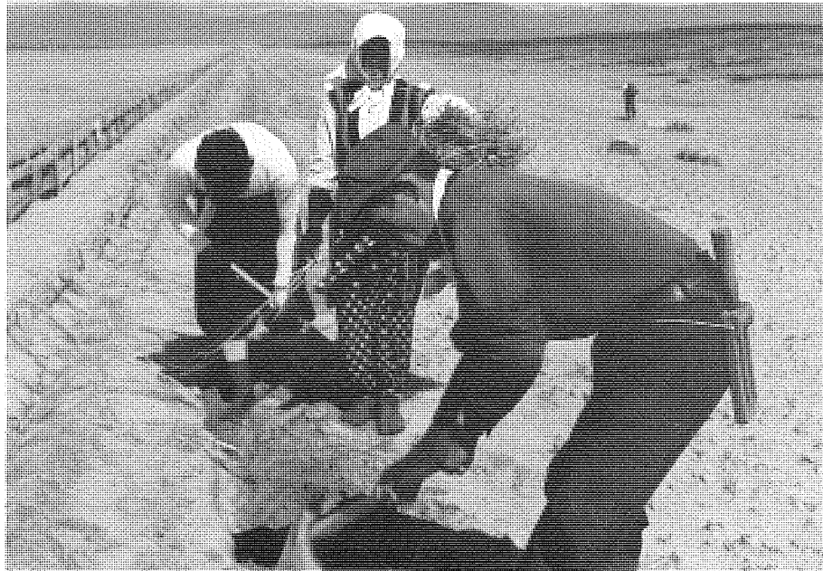
堆砂垣の後方にハマニンニクを植栽する。
