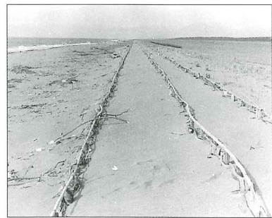
2/砂丘を造る 垣を設けて砂の山をつくり、後方への風の当たり方を弱くします。
