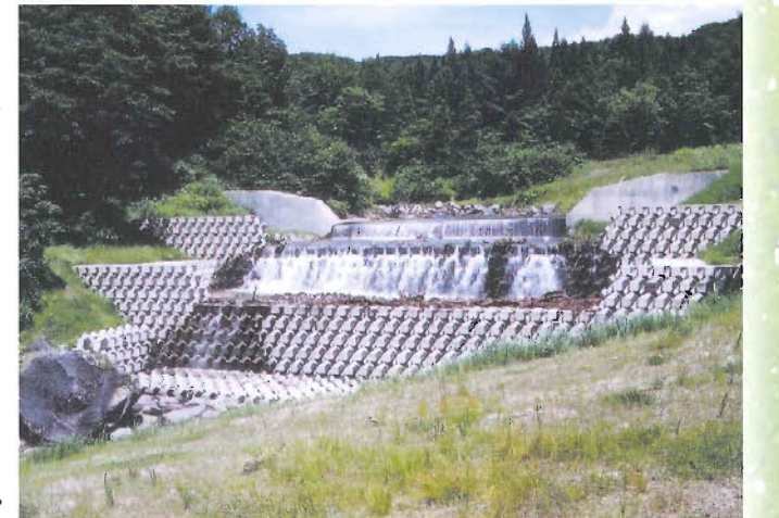
既設コンクリートブロックを再利用した谷止工。
