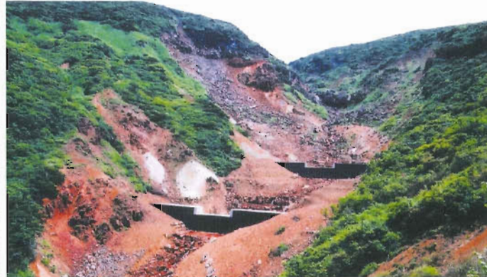
荒廃した仙人沢上流に山脚固定のため作られたスーパースチールダム。
