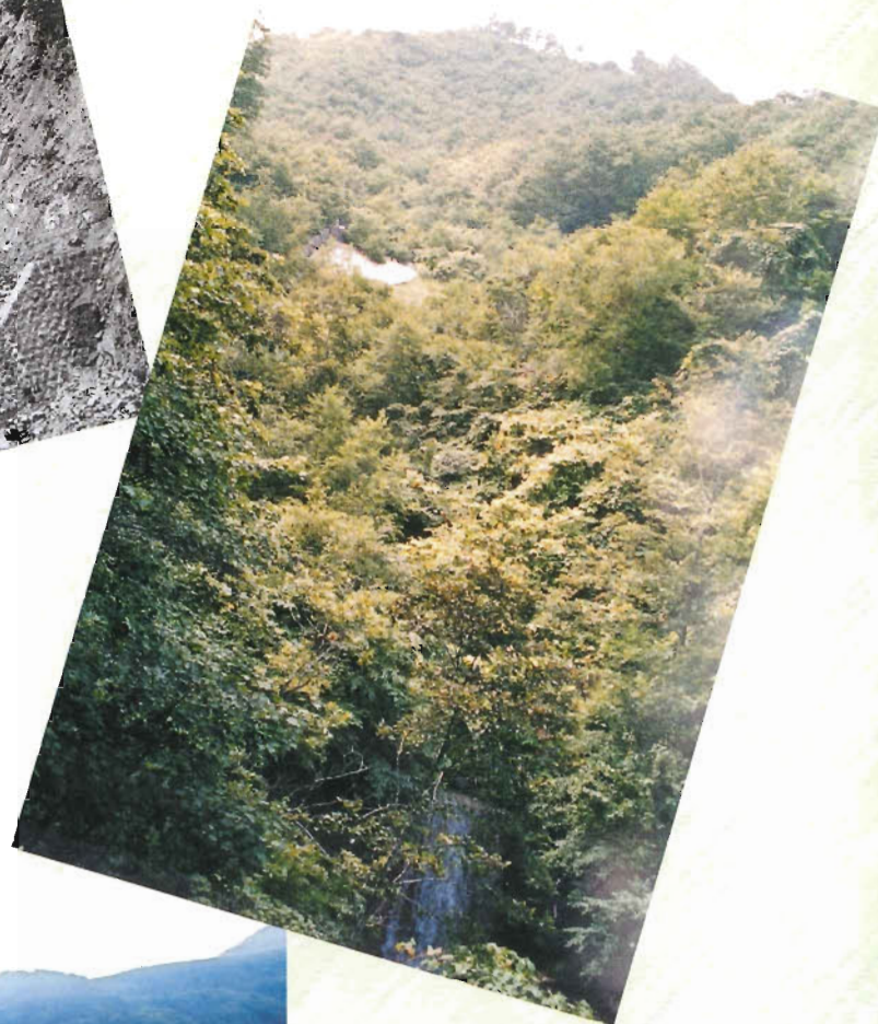
溪間工、山腹工の施工によって復旧した現況
