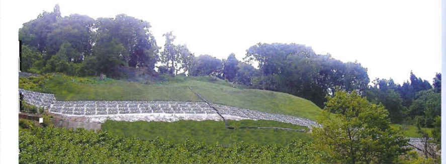
アンカーを帯状に配置し、地すべりを防ぐ。
