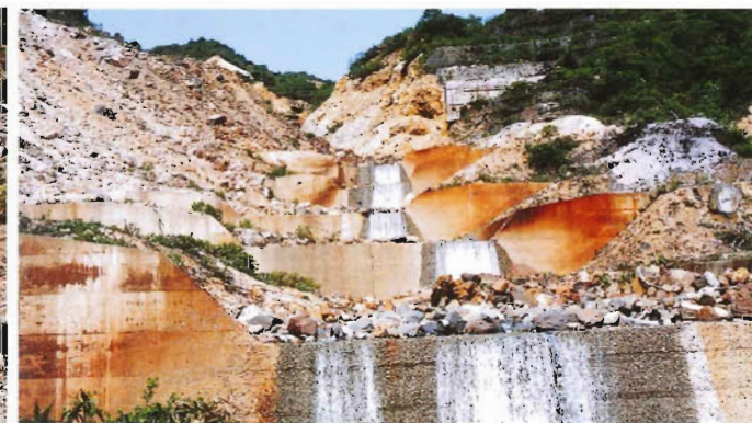
酸性を帯びた水と土壌により荒廃した蔵王川。山脚を抑え大規模な土砂流出を防いでいる治山ダム群。
