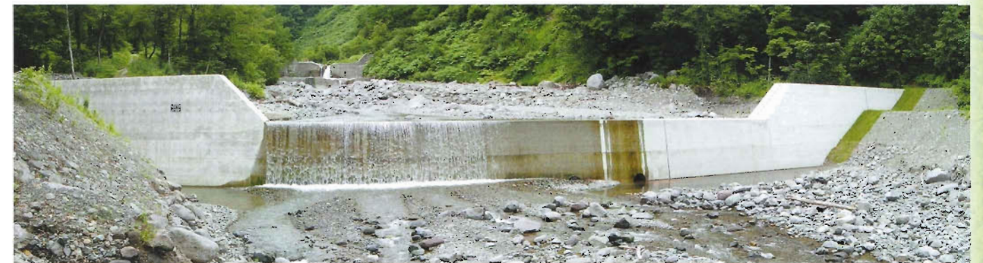
月山の水を集める四ッ谷川。流域が大きく、水量が豊富。治山ダムは、溪床の荒廃を防いでいる。
