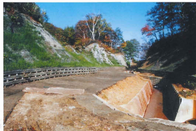
葉ノ木沢上流部の地すべり地ヨシ沼に流路工と山腹工、緑化工、管理歩道を施工した。
