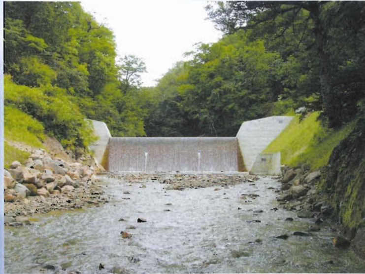
御所山(船形山)下流の溪床を安定させるためのコンクリート谷止
