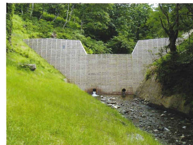
上流の土砂流出を防ぐため、また間伐材の有効利用と景観を考慮した谷止工。
