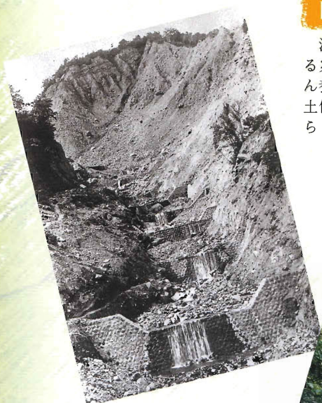
葉ノ木沢上流部の溪間工事と崩壊地の状況（昭和9年）
