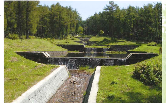
坊平高原の防火用水を溜めた床固工。付近の樹木を山林火災から守る。
