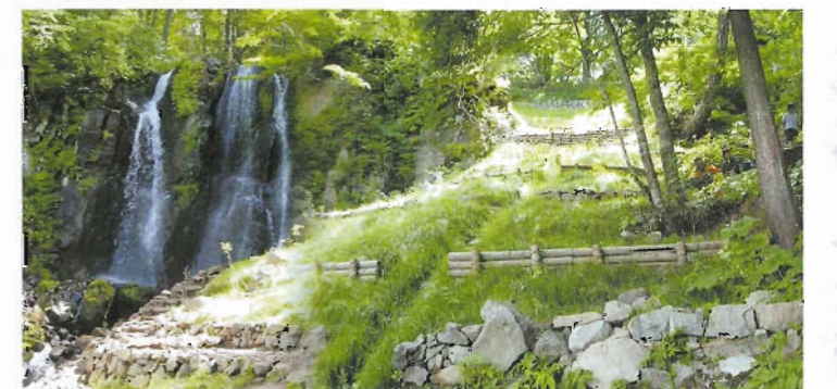
治山工事施工後。
