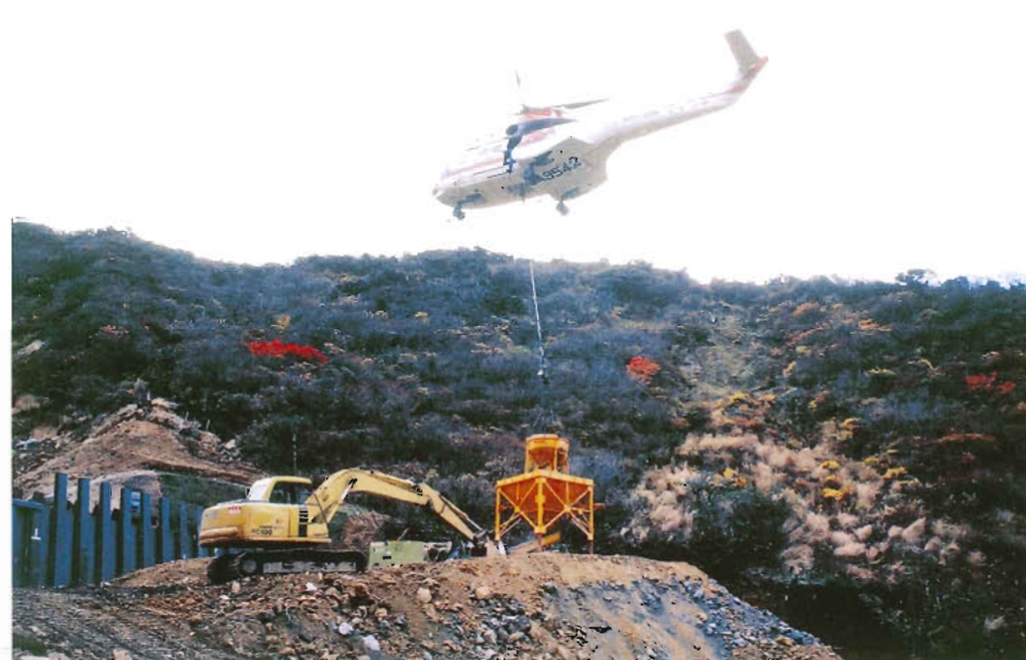
国定公園内のため、作業道作設ができず、ヘリによる施工となった。
