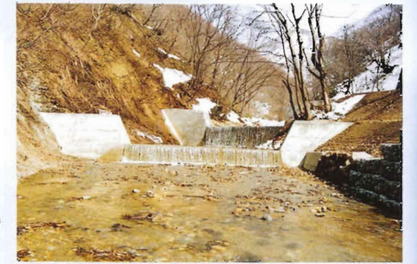
急峻で起伏に富む翁峠の下流域。溪岸の浸食を防いでいるコンクリート谷止。
