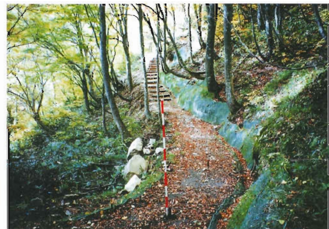
ヨシ沼周辺の管理歩道の整備を行っている。
