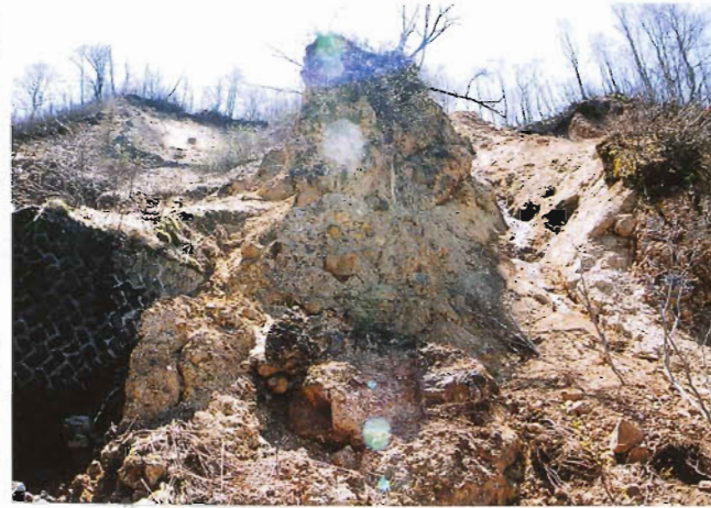
平成11年、崩落直後の祓川。火山性の成分、温度により変質した土質。周辺は硫黄の匂いが時おり下流から風によってくる。
