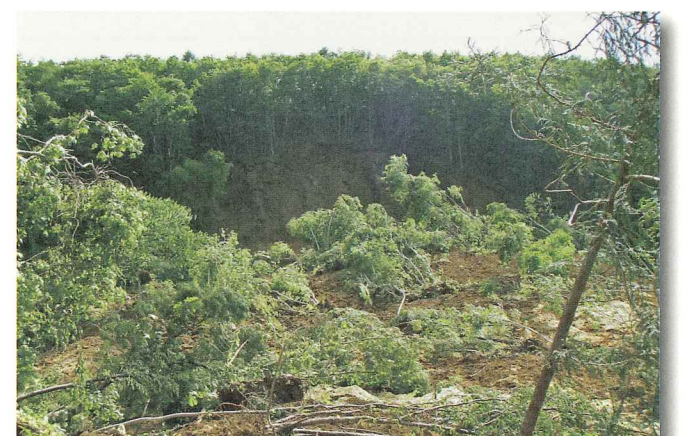
5 日影森区域 山腹崩壊地内の状況
