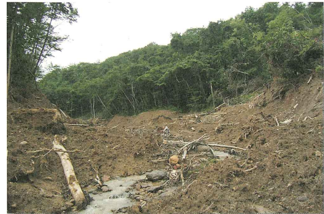
7 冷沢 下流の溪流荒廃状況
