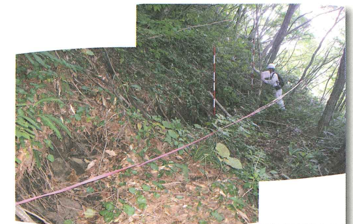
5 温湯区域 民家裏の山地内には亀裂が発生
