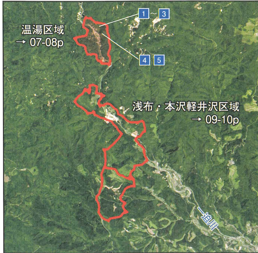
温湯区域全景 山腹および溪流荒廃状況と状況写真の位置 ALOS衛星画像(加筆) ©国土防災技術/INCLUDED©JAXA
