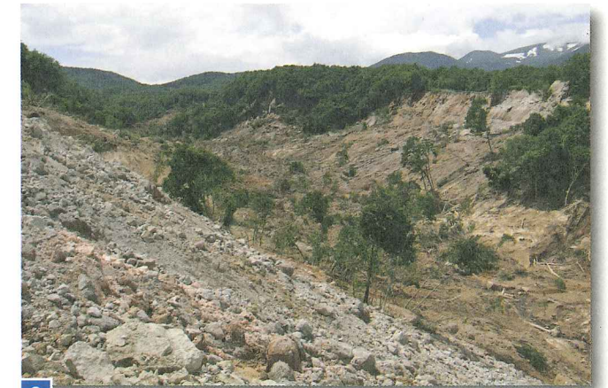
3 冷沢 山腹崩壊地内の荒廃状況
