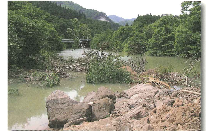
3 浅布区域 河道閉塞による湛水状況
