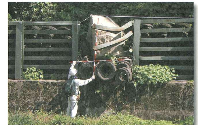
4 温湯区域 人家裏に迫る巨大な落石が防護柵を破壊
