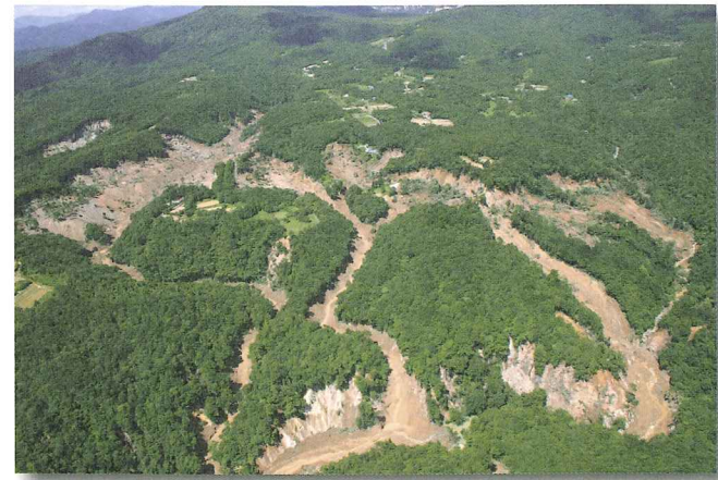
6 御沢支溪 山腹崩壊状況
