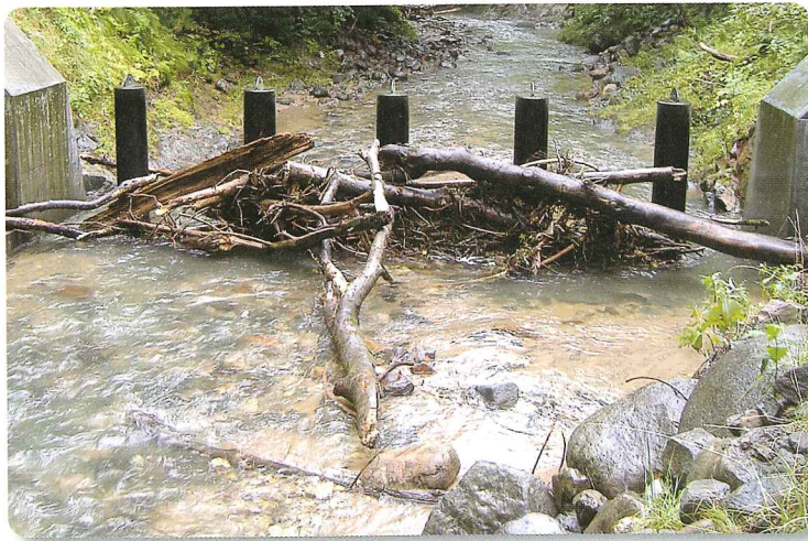
スリットダムでとらえられた流木
