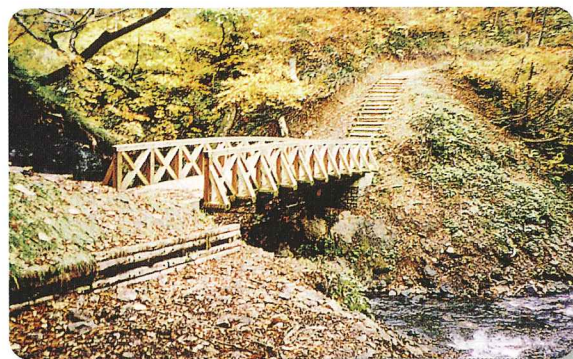
木製歩道橋 鮭川地区 (山形県鮭川村) <最上支署>
