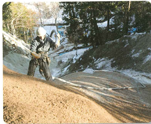
流木チップを混ぜた緑化基盤材を吹付けます （植物の種子は混合していない）
