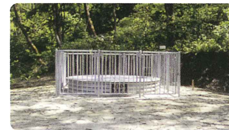
鋼製の集水井安全柵
