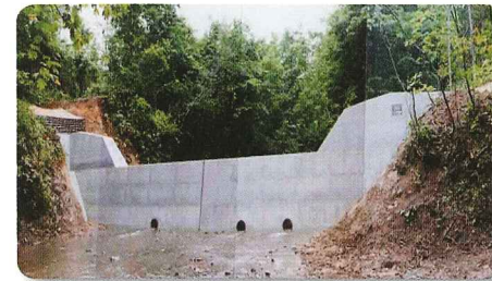
コンクリート治山ダム
