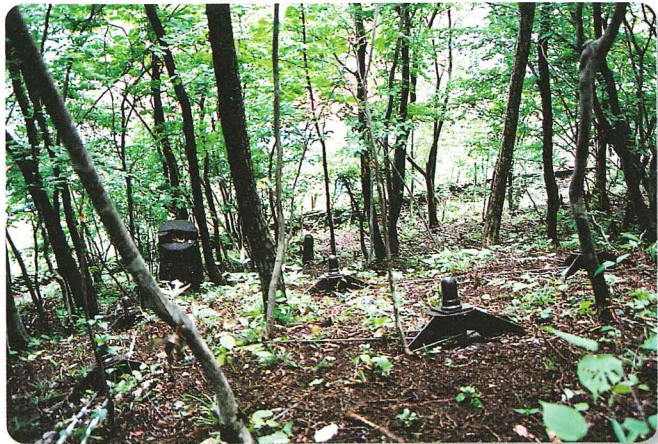
ノンフレーム工法による施工
