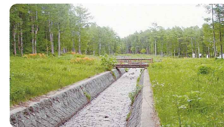
コンクリートブロック護岸工
