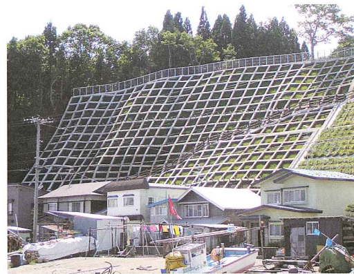
モルタル法枠工
