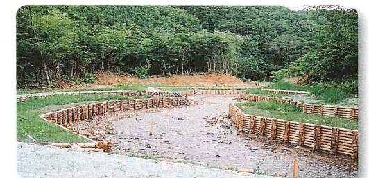
間伐材でつくった護岸工熊取沢(秋田県鹿角市)〈米代東部森林管理署〉
