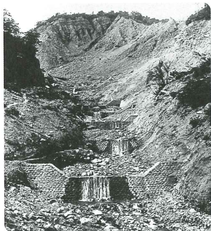
昭和初期につくられた治山ダム群
