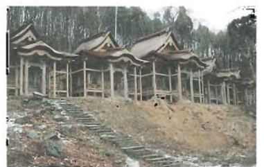
秋田 * 五社堂 ナマハゲの伝説が残る男鹿市の建築物。999段の石段もあります。
