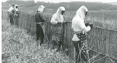
防風垣をつくる作業。
