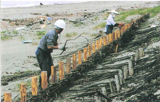
0.5m間隔で打ち込まれた防浪垣の杭と帯梢の編込み。
