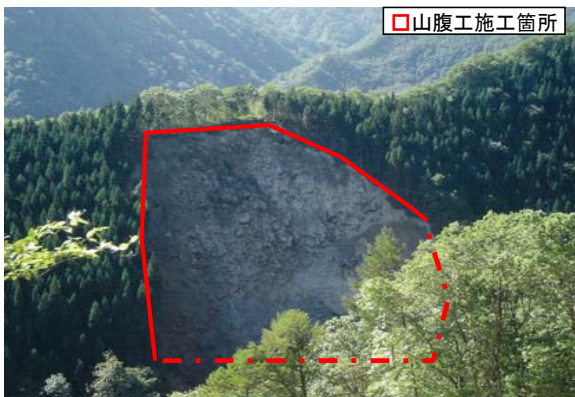
山腹工施工箇所
