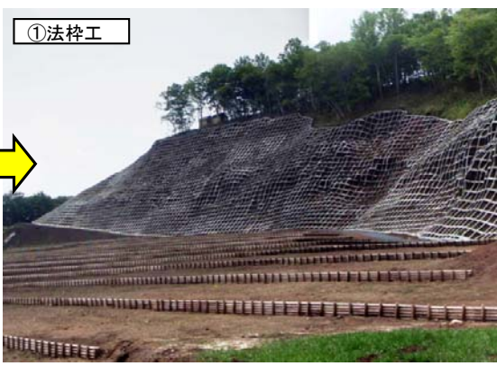
現在の復旧状況(法枠工及び土留工、山腹緑化工等を施工)
