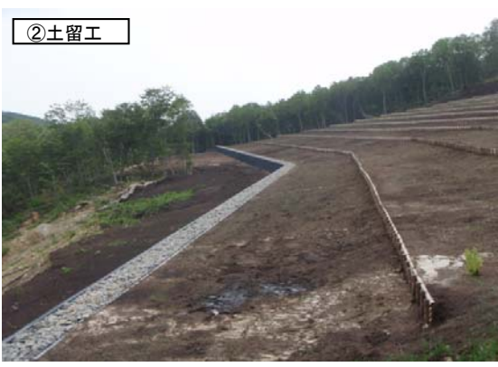
現在の復旧状況(法枠工及び土留工、山腹緑化工等を施工)
