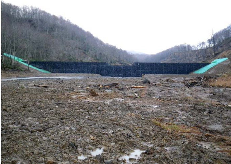
鋼製枠谷止工が完成しました。
