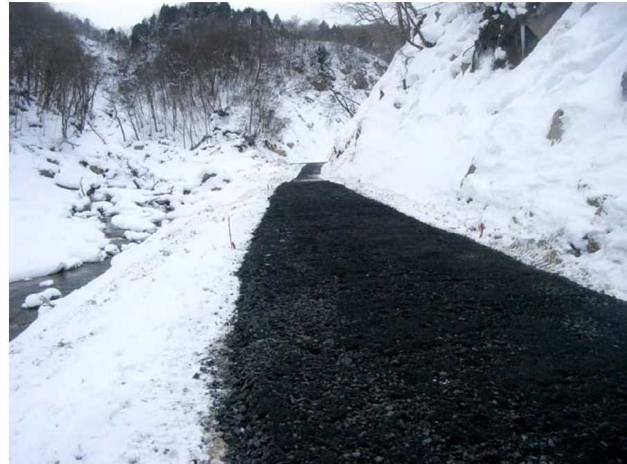
平成23年に谷止工を設置する箇所へ通じる 資材運搬路が完成しました。
