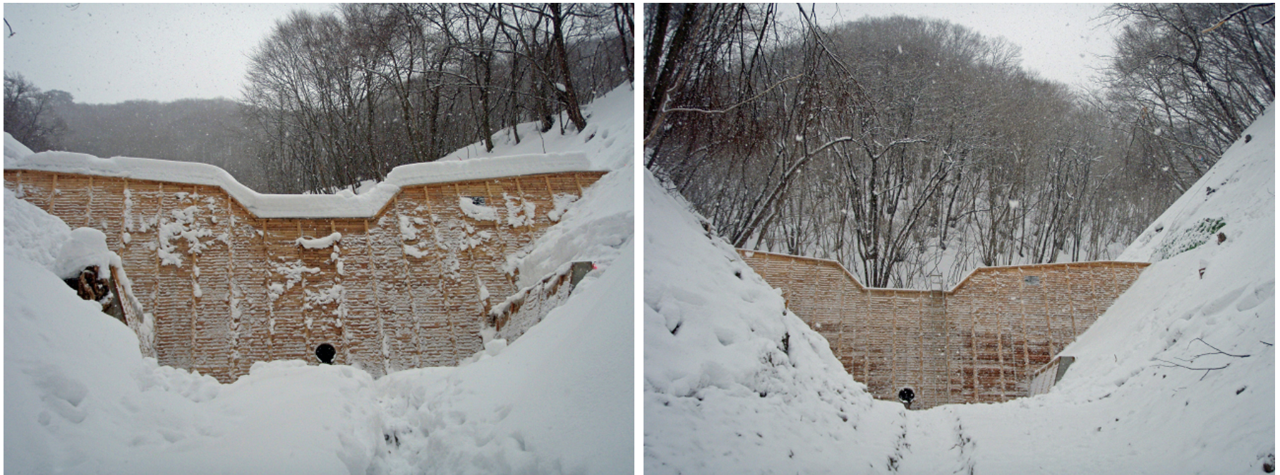
コンクリート谷止工及びコンクリート床固工が完成しました 表面は間伐材を利用した残存型枠です
