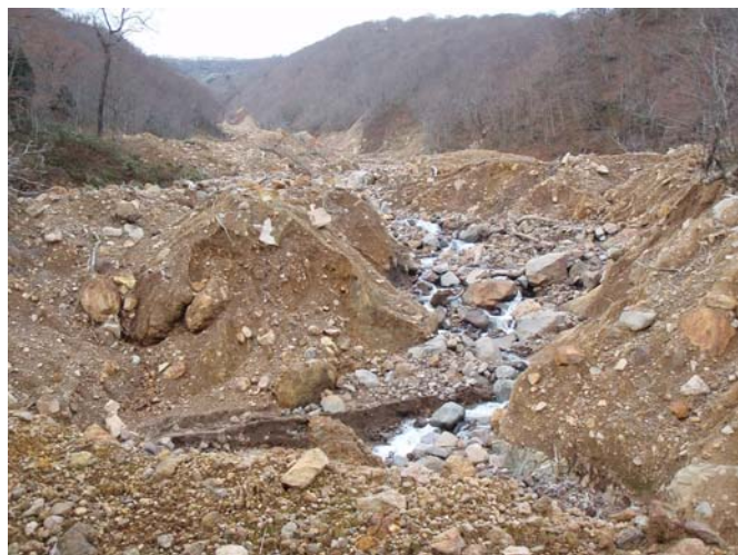
谷止工上流部 堆積土砂の様子
