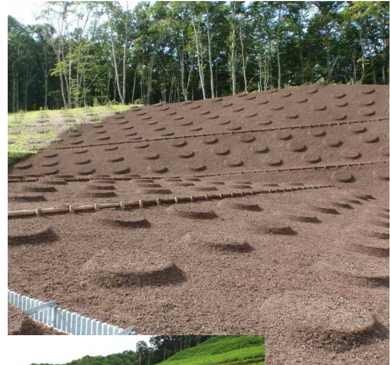
吹付直後の様子
