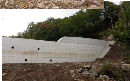
完成した谷止工
