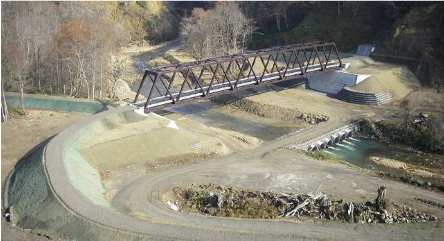
『河原小屋大橋』が完成しました
