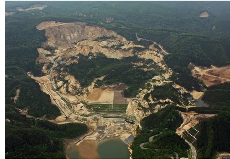
荒砥沢地区 (平成22年6月8日)
