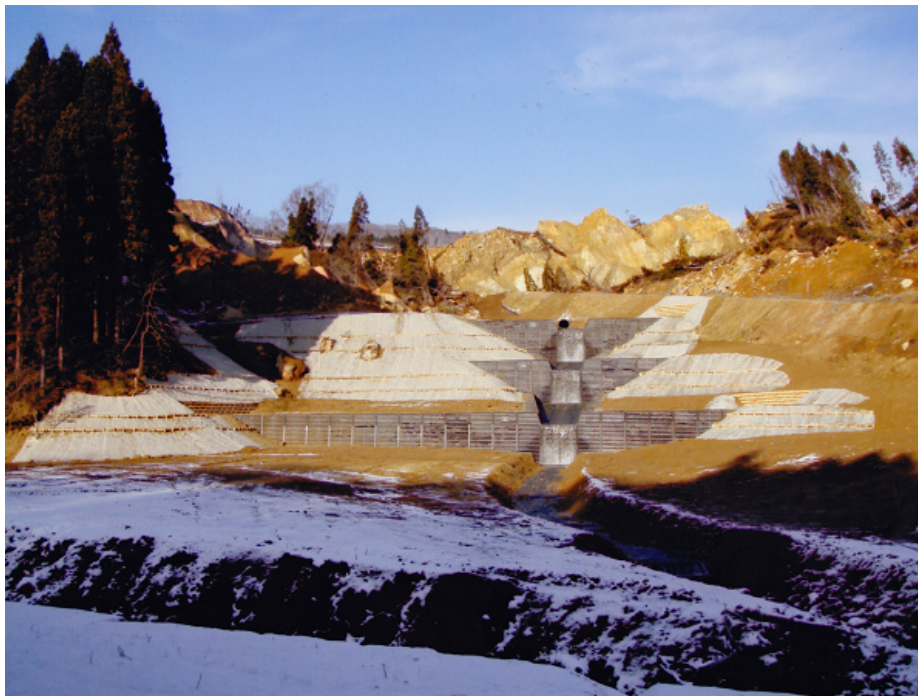
鋼製枠床固工が完成しました
