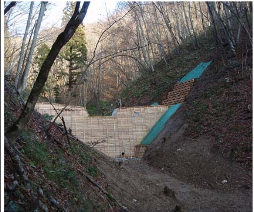
コンクリート谷止工が完成しました
