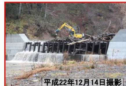
捕捉した流木等の除去
