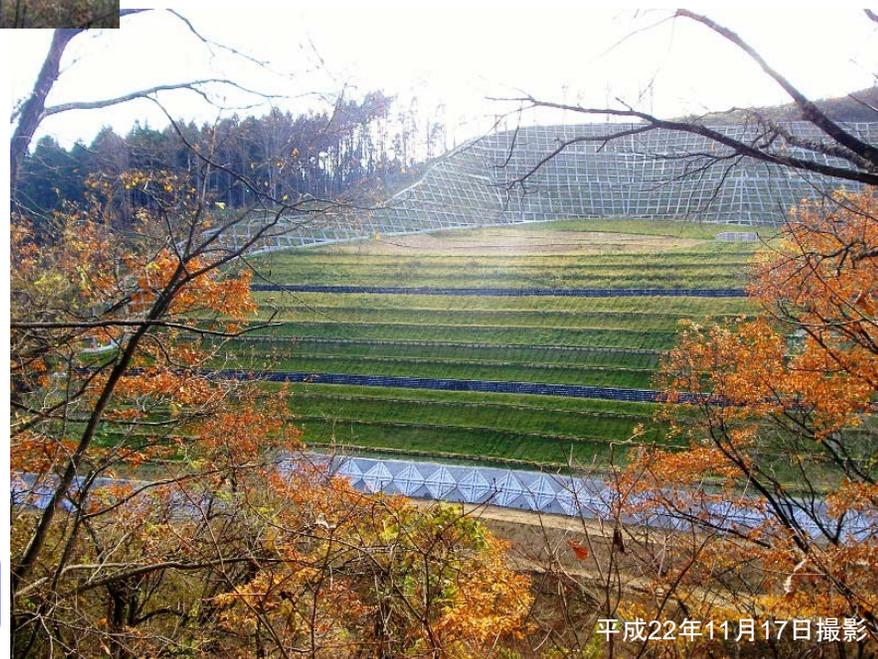
平成21年度は、不安定な斜面を安定させるため法砕工を行い、地すべりの原因となるすべり面付近の地下水を排除する集水井を設置しました。
