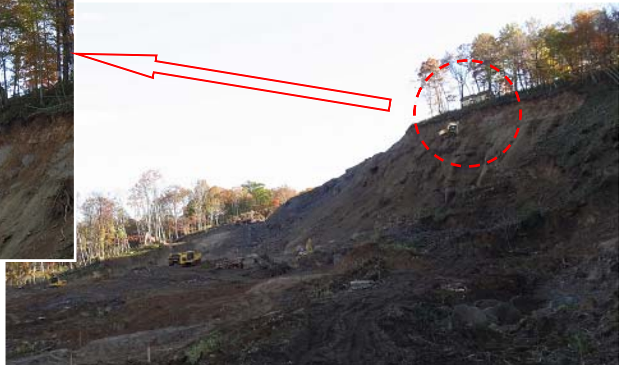
崩壊した斜面を整形・安定化させて緑化を図ります
