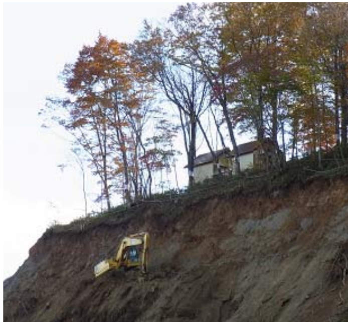
切土を行っているバックホウ
