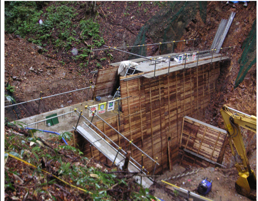
コンクリート谷止工を作っています 表面は間伐材を利用した残存型枠です
