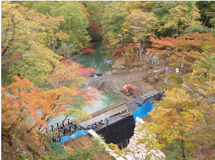
鋼製枠谷止工を作っています
