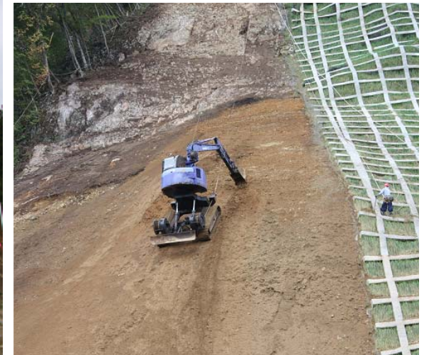
斜面を整形する高所斜面掘削機
