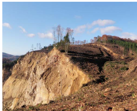
工事前 (平成21年11月4日)
