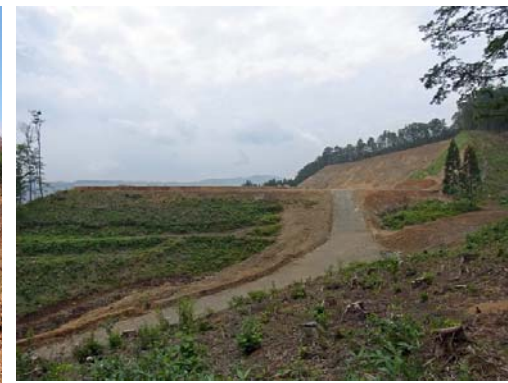
工事完成 (平成22年8月4日)
