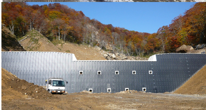
INSEM鋼製谷止工 平成21年10月完成
