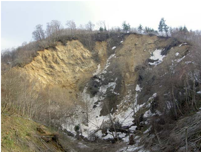
施工前の崩壊斜面
