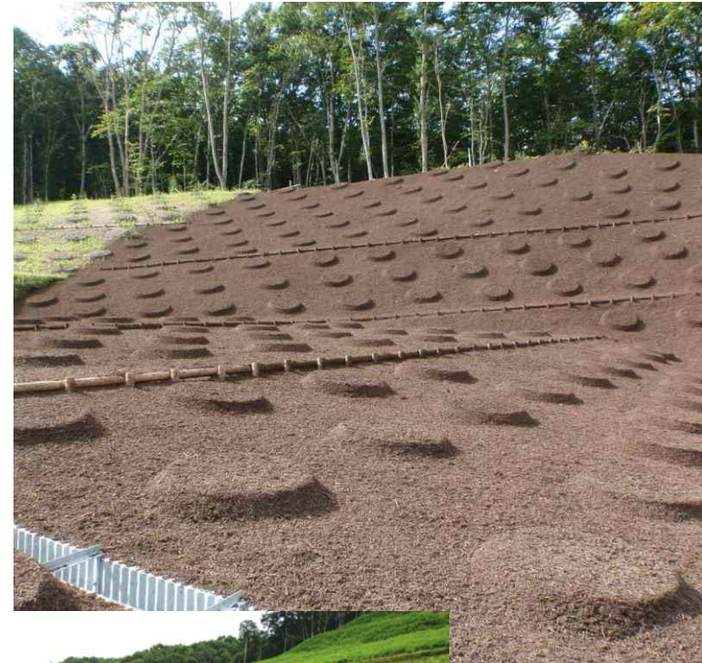
吹付直後の様子
