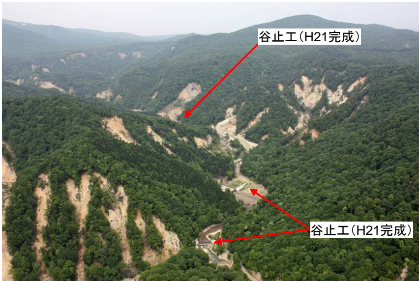
一迫川上流 川原小屋沢の荒廃状況 (平成22年6月8日)
