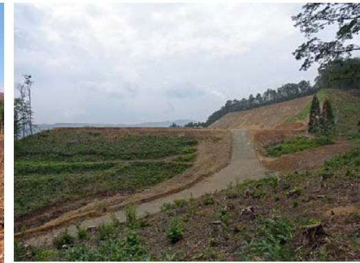
工事完成 (平成22年8月4日)
