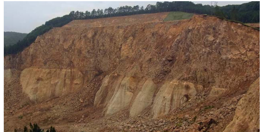
不安定な崖の上部の土(37万m 3 )を取り除きました (平成22年8月4日)
