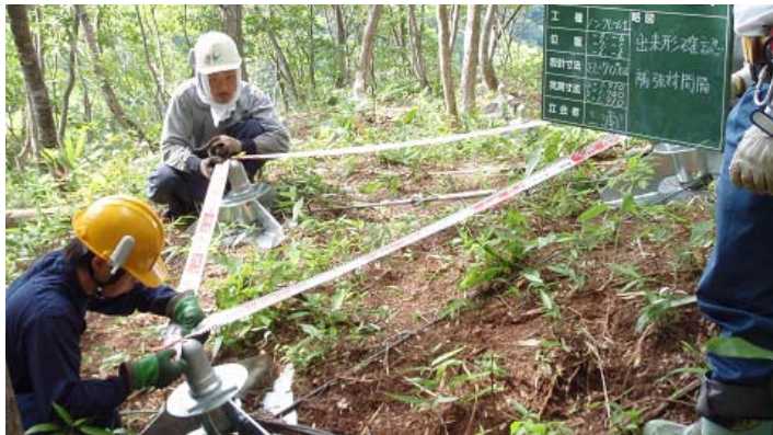
工事の品質を保つため検査・立会を行っています
