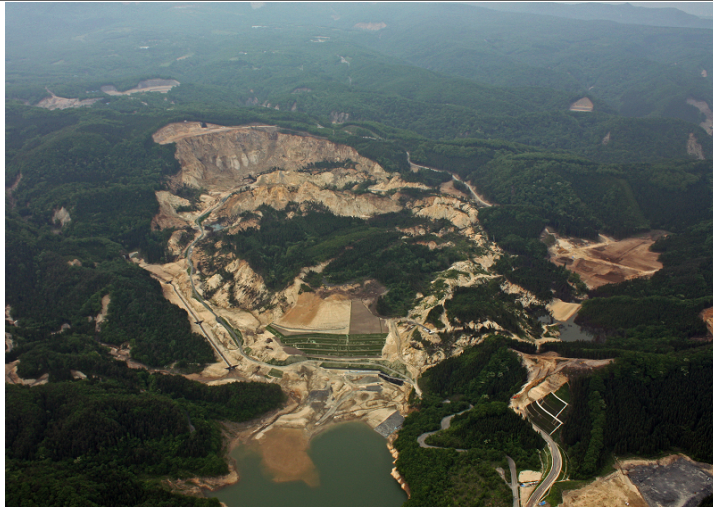
荒砥沢地区 (空撮) (平成22年6月8日)
