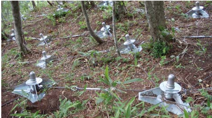
森林を残したままで、斜面の崩壊を防止する 地山補強土工を行っています
