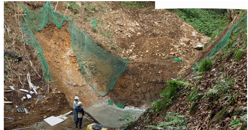
コンクリート谷止工の新設のため掘削しました
