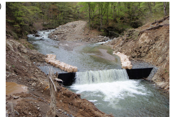
鋼製樁谷止工施工箇所
