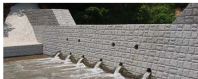
コンクリート谷止工
