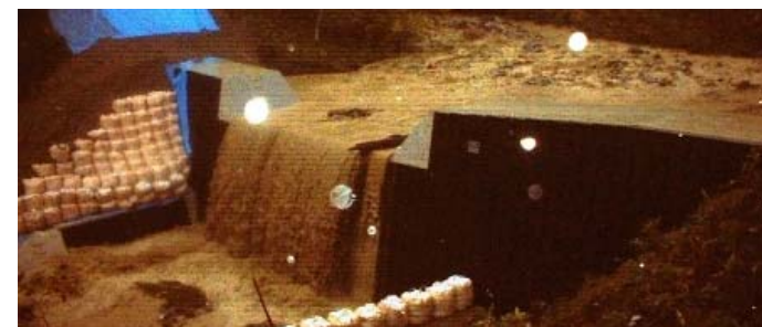
INSEM鋼製谷止工
