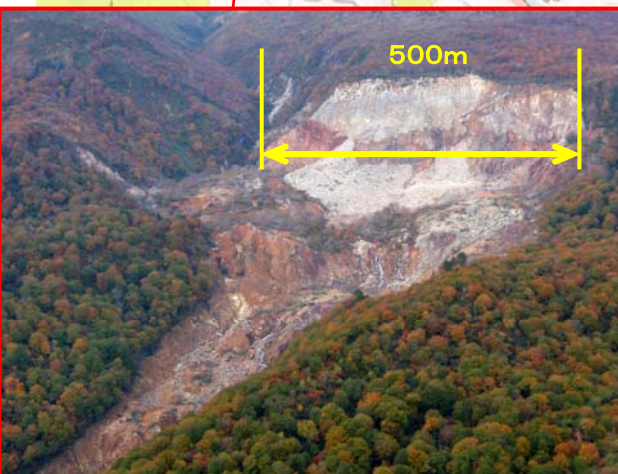
産女川上流部の 荒廃状況 (平成21年10月13日)
