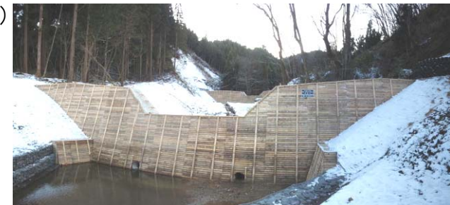
コンクリート谷止工(間伐材を利用した型枠)
