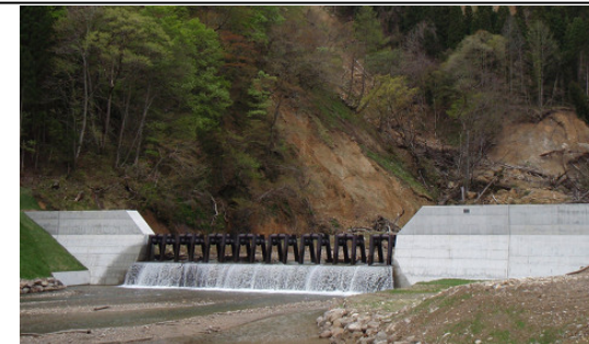
鋼製スリット式谷止工
