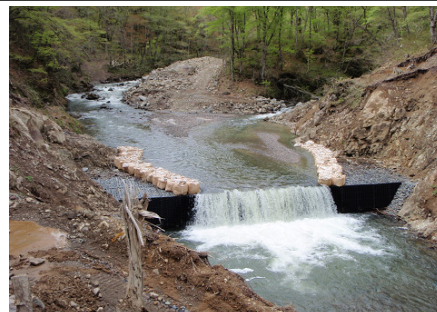
鋼製枠谷止工施工箇所
