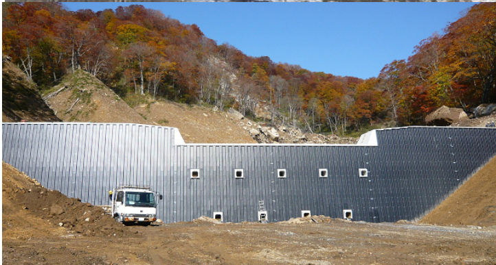
INSEM鋼製谷止工 平成21年10月完成
