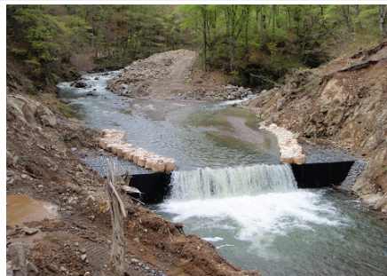
鋼製樁谷止工施工箇所
