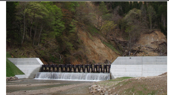
鋼製スリット式谷止工
