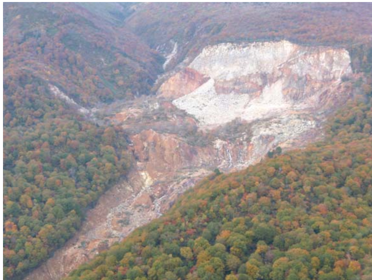
産女川上流部の荒廃状況 (平成21年10月13日)
