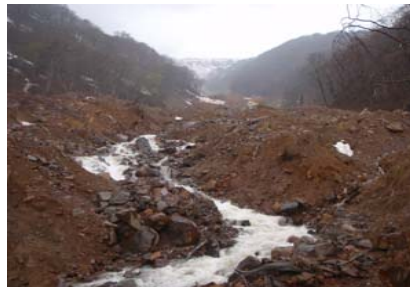
産女川ダム工施工箇所
