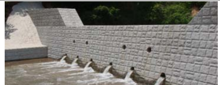
コンクリート谷止工
