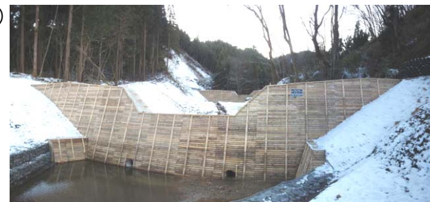
コンクリート谷止工(間伐材を利用した型枠)
