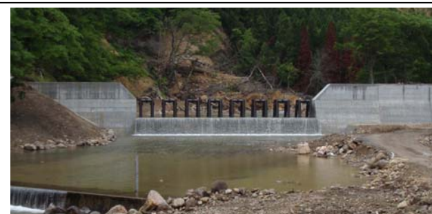
鋼製スリット式谷止工
