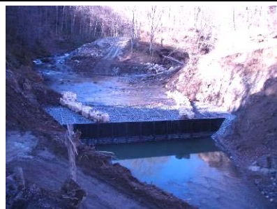
鋼製樁谷止工施工箇所
