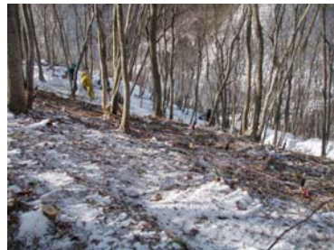
地山補強土工施工状況 (平成22年1月22日)
