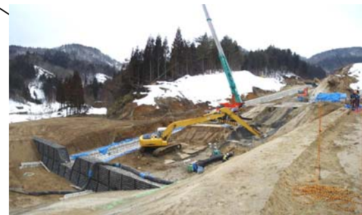
ブロック水路工施工状況(平成22年2月26日)
