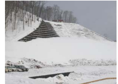
吹付砕工施工完成(平成22年2月19日)
