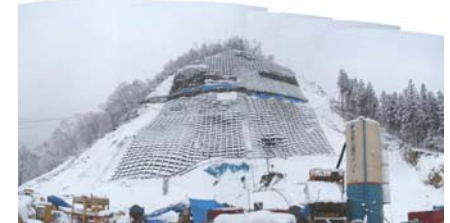
吹付砕工施工状況(平成22年3月2日)
