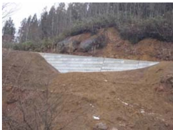
11号工事状況(平成21年12月11日)
