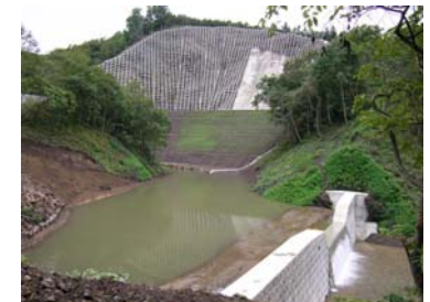
山腹工 工事完成(平成21年8月31日)
