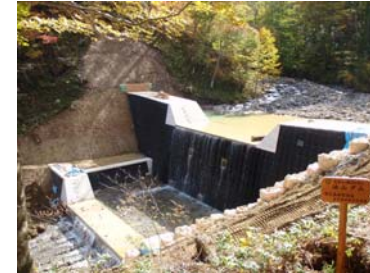
谷止工 工事状況(平成21年10月15日)
