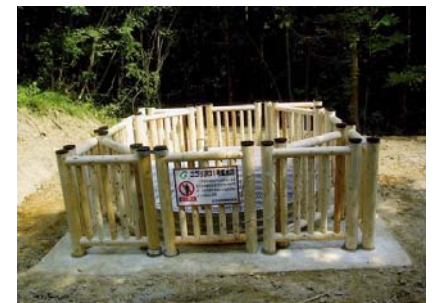
集水井完成状況(平成21年7月27日)
