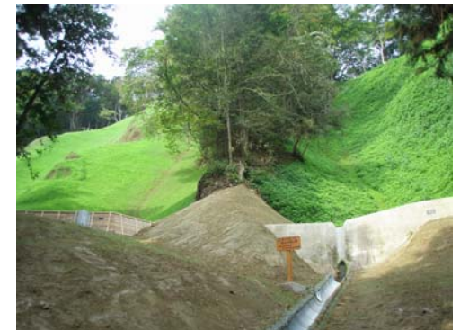
山腹工 工事状況 (平成21年9月18日)
