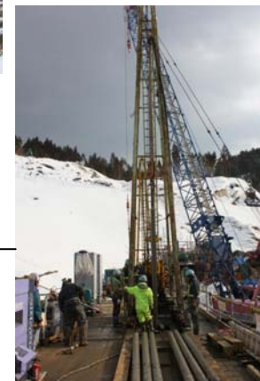
杭打工施工状況(平成22年1月20日)
