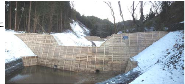
谷止工完成 (平成21年12月17日)
