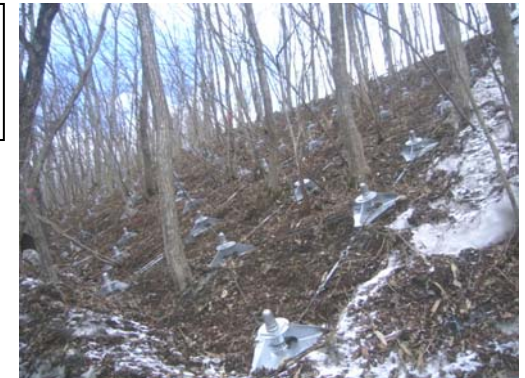
地山補強土工施工状況 (平成22年1月27日)
