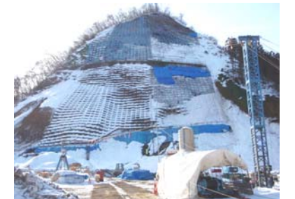
吹付砕工施工状況(平成22年1月22日)
