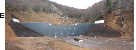
谷止工 完成(平成21年11月4日)
