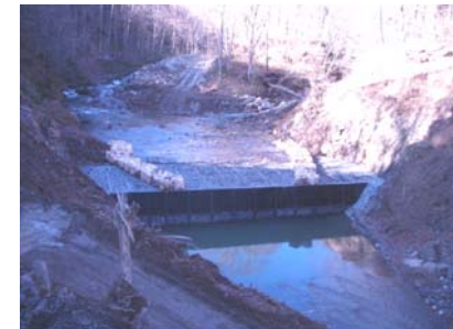
谷止工終了状況(平成21年12月7日)
