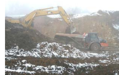
排土工施工状況(平成22年1月12日)
