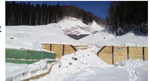
谷止工完成(平成22年2月4日)
