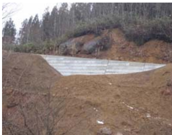
11号工事状況(平成21年12月11日)
