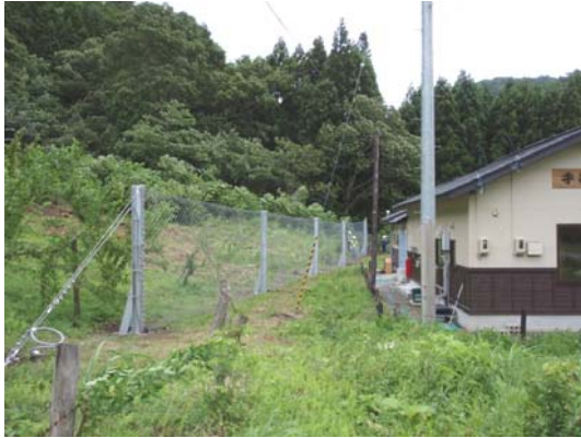
落石防護柵の設置(平成21年7月13日)
