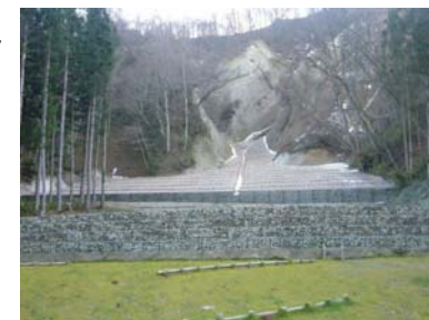
土留工ほか 完成 (平成21年12月10日)
