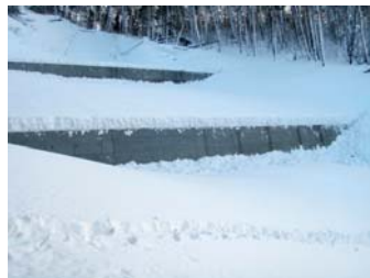
土留工完成 (平成22年1月7日)
