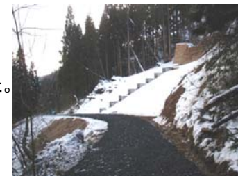
完成(平成21年12月24日)
