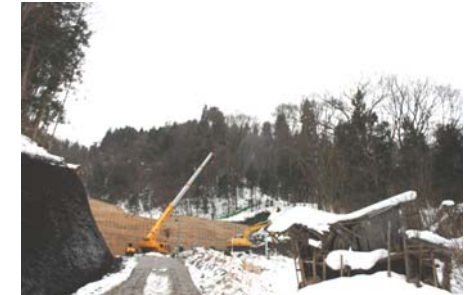
谷止工施工状況 (平成22年1月25日)
