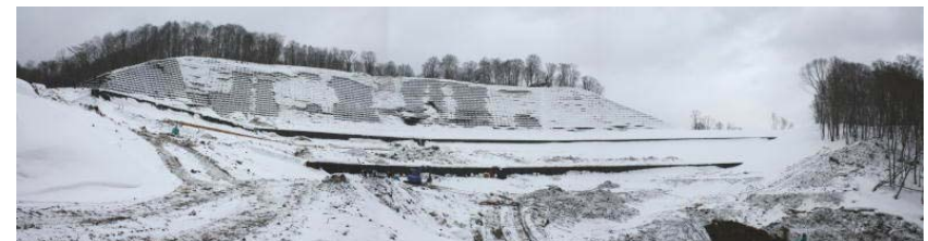
吹付砕工ほか施工状況(平成22年1月25日)
