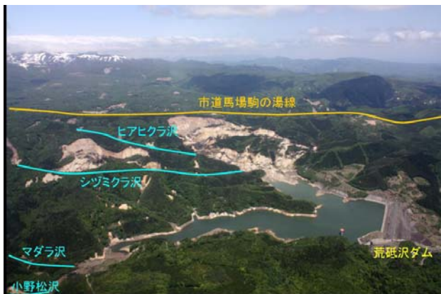
荒砥沢ダム周辺荒廃状況(平成21年5月15日)
