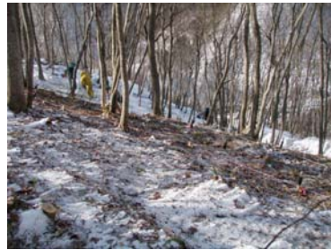
地山補強土工施工状況 (平成22年1月22日)
