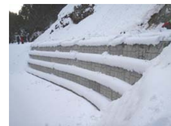
完成(平成21年12月24日)
