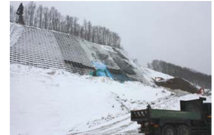
吹付砕工施工状況(平成22年1月25日)
