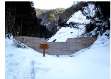
谷止工完成(平成22年2月2日)
