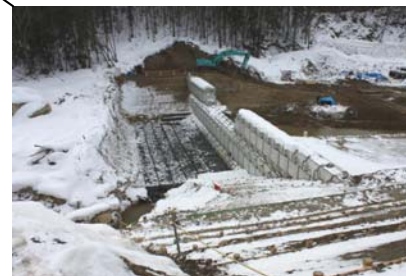
谷止工施工状況(平成22年1月27日)
