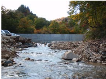
谷止工 工事状況 (平成21年10月15日)
