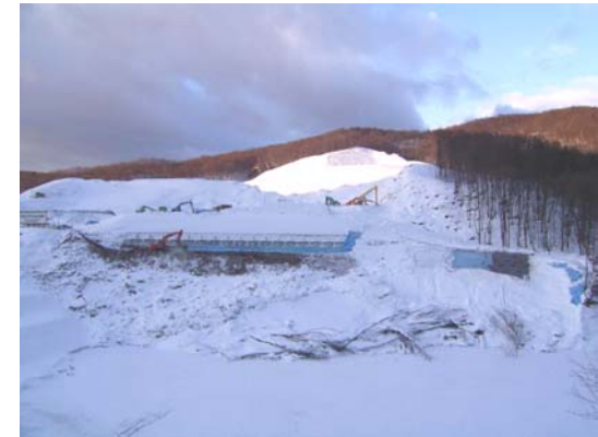
施工状況(平成22年1月28日)
