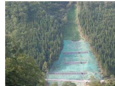
山腹工. 完成状況(平成21年10月27日)
