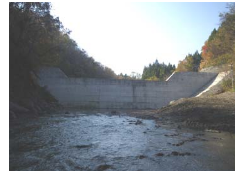
産女川2号 谷止工 工事完成(平成21年10月27日)
