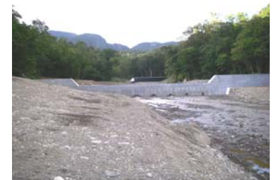
コンクリート谷止工 工事完成(平成21年9月15日)
