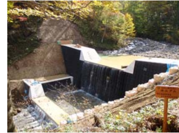
谷止工 工事状況(平成21年10月15日)
