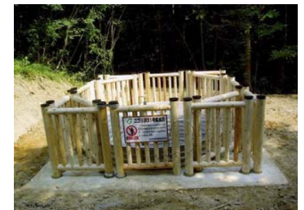
集水井完成状況(平成21年7月27日)
