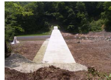
コンクリート谷止工 (平成21年7月15日)
