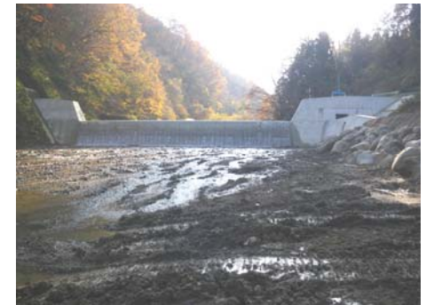
産女川1号 谷止工 工事完成(平成21年10月27日)
