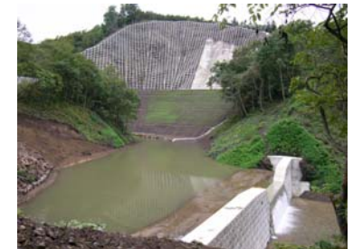
山腹工 工事完成(平成21年8月31日)
