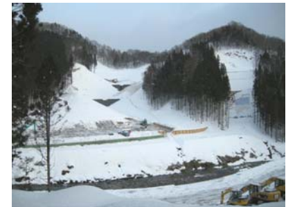
山腹工施工状況(平成21年12月16日)
