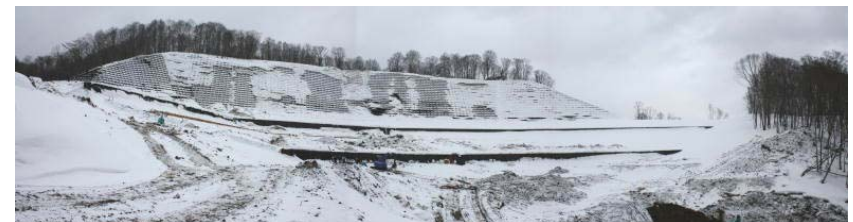
吹付砕工ほか施工状況(平成22年1月25日)
