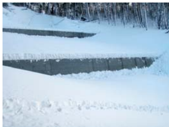
土留工完成 (平成22年1月7日)
