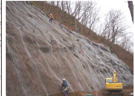
1号工事状況 (平成21年12月11日)
