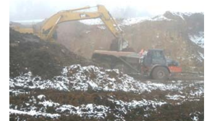
排土工施工状況(平成22年1月12日)
