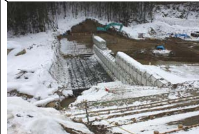
谷止工施工状況(平成22年1月27日)
