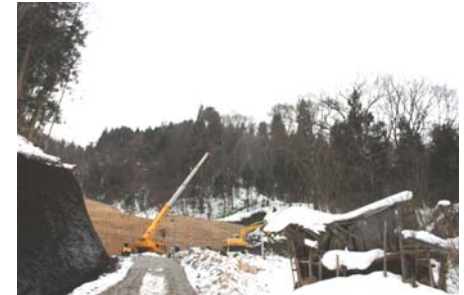
谷止工施工状況 (平成22年1月25日)
