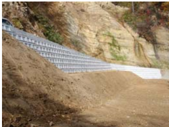
9号工事状況(平成21年10月21日)
