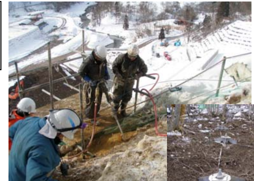
地山補強土工施工状況 (平成22年1月26日)
