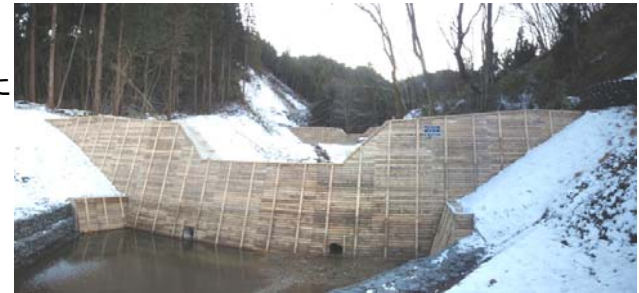
谷止工完成 (平成21年12月17日)
