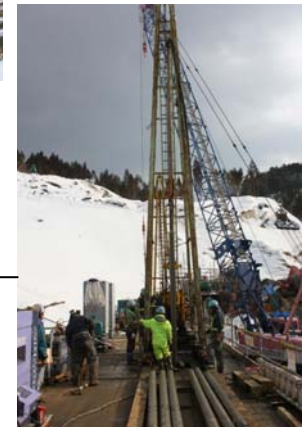
杭打工施工状況(平成22年1月20日)
