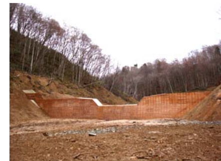
谷止工施工状況(平成21年11月17日)
