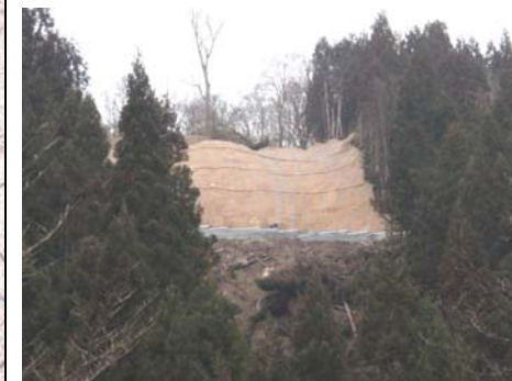
4号工事状況 (平成21年12月11日)
