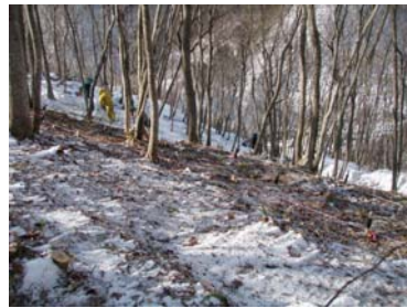
地山補強土工施工状況 (平成22年1月22日)
