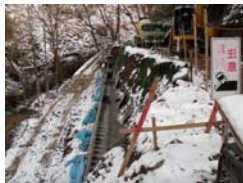
1号ブロック積工 (平成21年11月19日)
