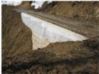
二段式擁壁完了
