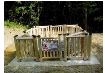
集水井完成状況(平成21年7月27日)
