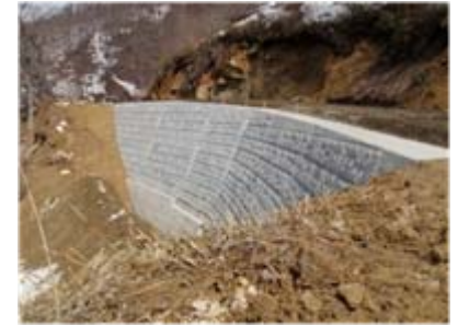
コンクリートブロック擁壁完了
