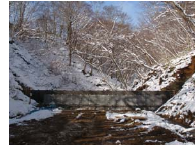
コンクリート谷止工 工事状況(平21年12月17日)
