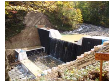
谷止工 工事状況(平成21年10月15日)
