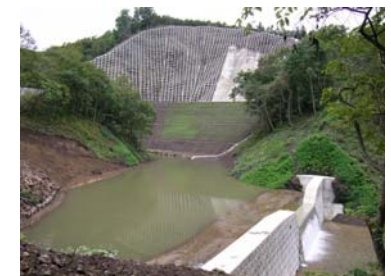
山腹工 工事完成(平成21年8月31日)
