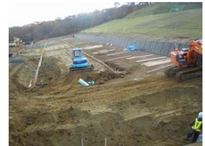
施工状況(平成21年11月5日)
