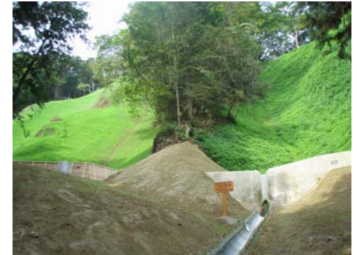
山腹工 工事状況 (平成21年9月18日)
