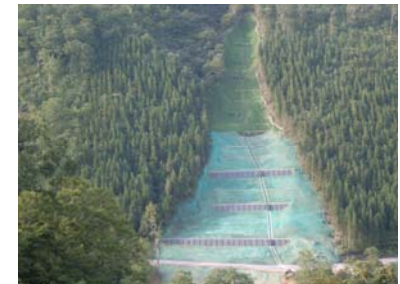
山腹工. 完成状況(平成21年10月27日)
