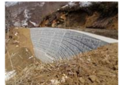
コンクリートブロック擁壁完了
