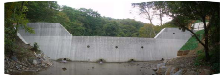
コンクリート谷止工 工事完成(平21年9月15日)
