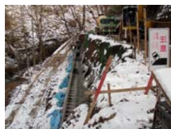
1号ブロック積工 (平成21年11月19日)
