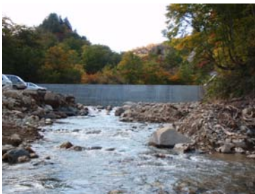
谷止工 工事状況 (平成21年10月15日)
