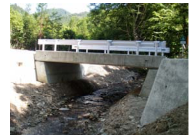
橋梁付替(平成21年6月25日)
