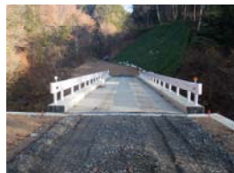
渋民3-2号、橋梁工2完成 (平成21年11月6日)
