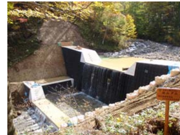
谷止工 工事状況(平成21年10月15日)
