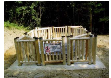
集水井完成状況(平成21年7月27日)
