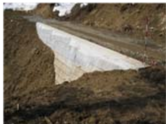
二段式擁壁完了
