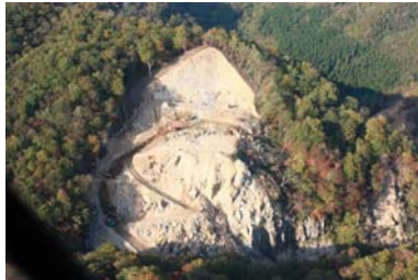
切土工施工状況(平成21年10月14日)
