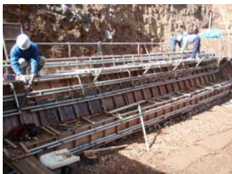
11号施工状況(平成21年10月21日)
