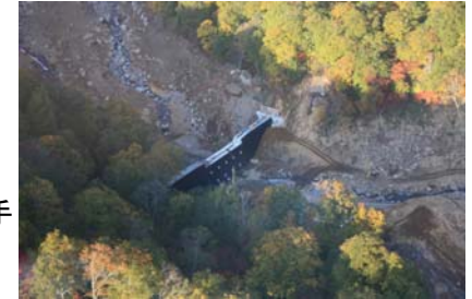
鋼製谷止工の施工状況(平成21年10月14日)
