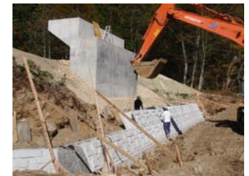
右岸側護岸工事状況 (平成21年10月15日)
