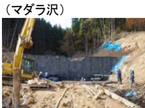
鋼製谷止工施工状況 (平成21年10月22日)
