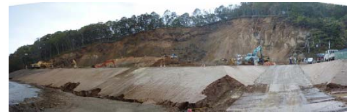
法切工施工状況(平成21年10月9日)
