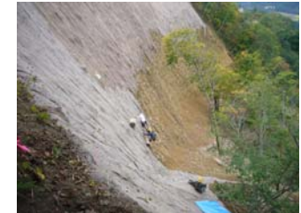
上部法面伏工施工状況 (平成21年10月1日)
