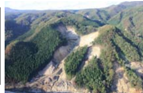
施工箇所全景(平成21年10月14日)
