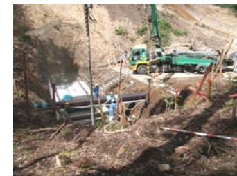
谷止工 工事状況 (平成21年9月14日)
