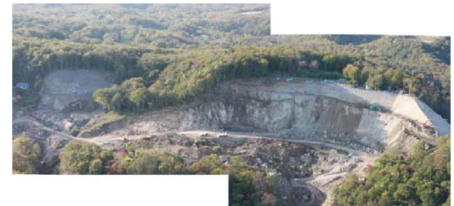
施工地の全景(平成21年10月14日)
