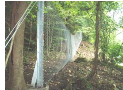
落石防護柵の設置(平成21年8月28日)
