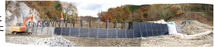
鋼製自在枠床固工施工状況(平成21年10月22日)
