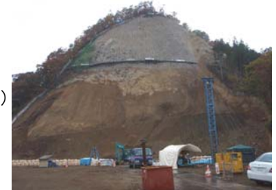
法砕工施工状況(平成21年10月19日)
