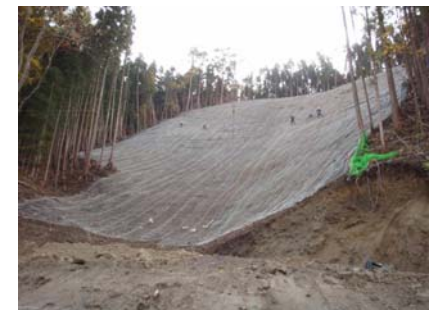
法枠工施工状況(平成21年10月28日)
