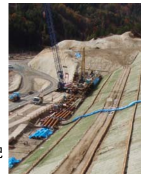
杭打工施工状況 (平成21年10月22日)
