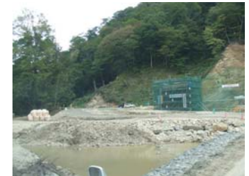
トラス橋左岸橋台状況 (平成21年10月15日)
