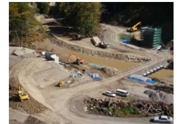
工事状況全景(平成21年10月15日)
