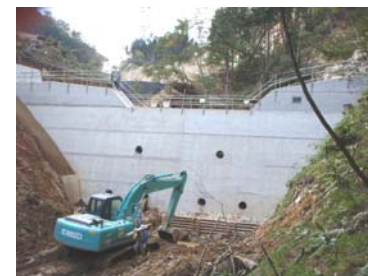
谷止工施工状況(平成21年10月1日)
