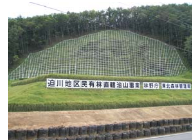
吹付砕工 (完成:平成21年8月4日)
