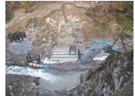
谷止工施工状況(平成21年10月22日)
