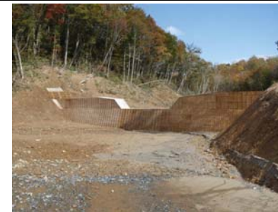
谷止工施工状況(平成21年10月20日)
