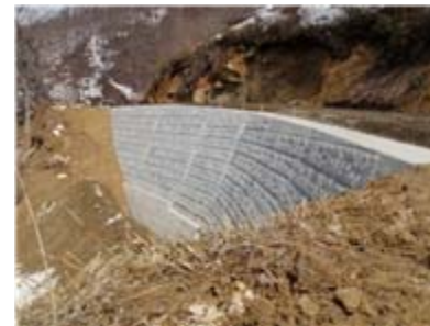
コンクリートブロック擁壁完了
