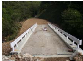
渋民3-2号、橋梁工 工事状況(平成21年9月14日)
