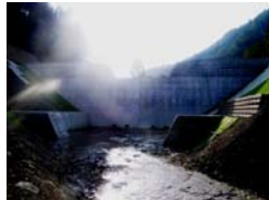
コンクリート谷止工完成 (平成21年9月30日)
