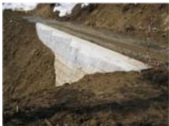
二段式擁壁完了
