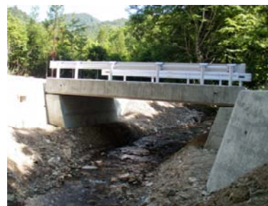
橋梁付替(平成21年6月25日)
