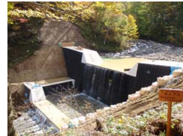
谷止工 工事状況(平成21年10月15日)
