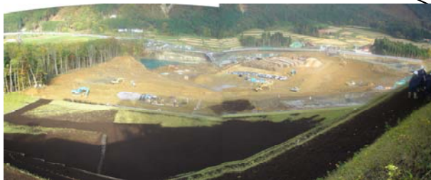
(市野々原) 全景(平成21年10月27日)
