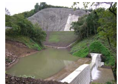
山腹工 工事完成(平成21年8月31日)
