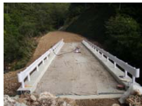
渋民3-2号、橋梁工 工事状況(平成21年9月14日)
