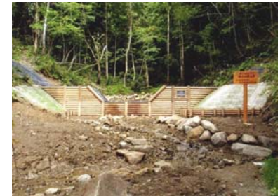
工事完成(平成21年8月11日)
