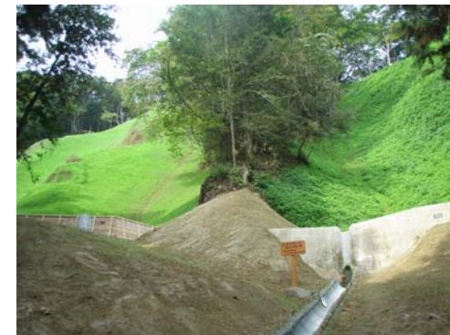
山腹工 工事状況 (平成21年9月18日)
