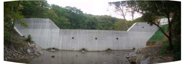
コンクリート谷止工 工事完成(平21年9月15日)
