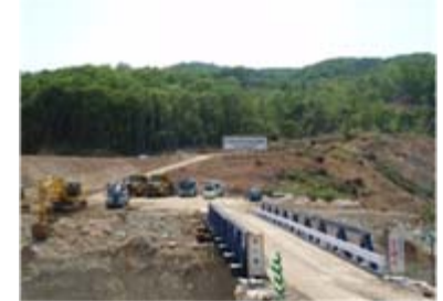
工事状況(平成21年5月26日)
