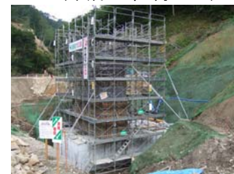
トラス橋左岸橋台鉄筋組立状況 (平成21年9月16日)
