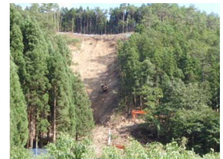
法切工施工状況(平成21年9月7日)
