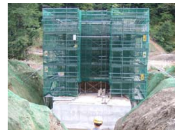
トラス橋右岸橋台鉄筋組立状況 (平成21年9月16日)
