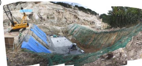
ブロック谷止工施工状況(平成21年9月11日)
