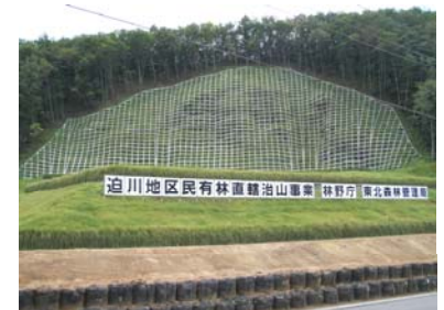
吹付砕工 (平成21年8月4日)
