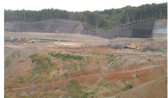
工事状況(平成21年9月15日)
