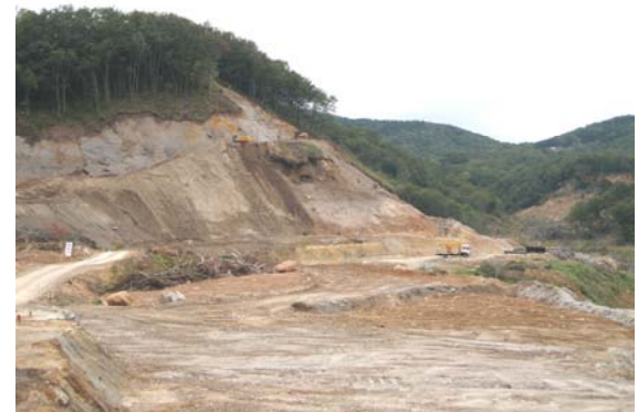
工事状況(平成21年9月8日)
