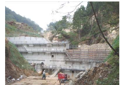
谷止工施工状況(平成21年8月20日)
