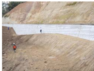
(3～11号)7号工事状況 (平成21年9月15日)
