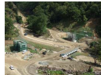
工事状況全景(平成21年9月16日)
