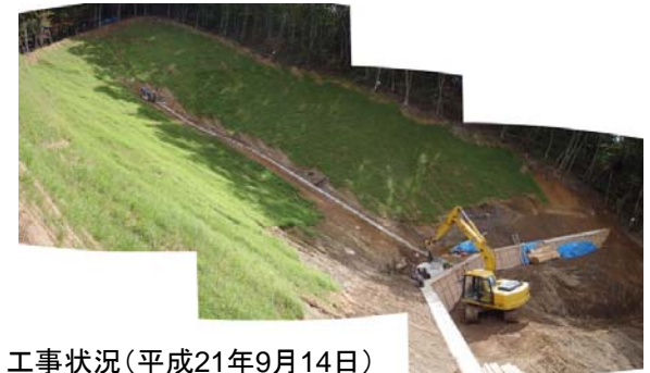
緑化工、水路工 工事状況(平成21年9月14日)
