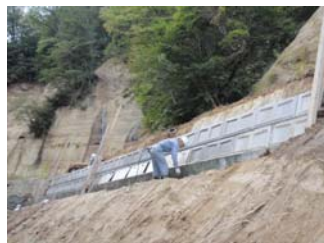
8号工事状況(平成21年9月15日)
