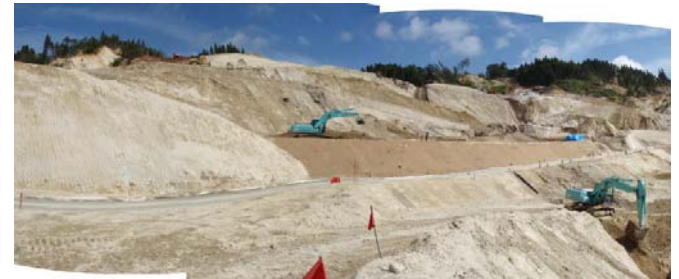
施工状況(平成21年9月7日)
