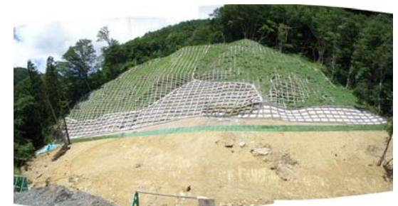
法砕工施工状況(平成21年8月24日)
