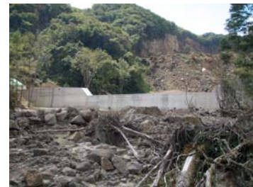
谷止工完成(平成21年9月14日)
